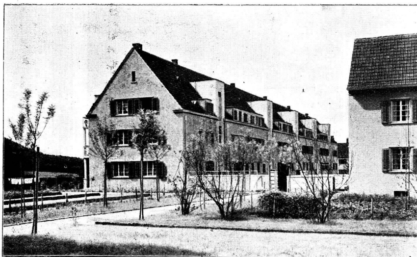
Hintermeisterhof 1 re étape de construction de maisons collectives.
