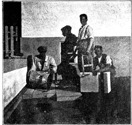
Isolation d'une terrasse sur des locaux habités. Béton cellulaire de 8 cm d'épaisseur. Poids spécifique 0,5.
