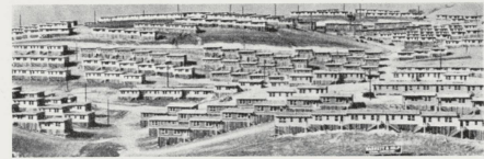
Die Frage der demontierbaren Häuser spielte für die großen Industriesiedlungen eine hervorragende Rolle. Ein Teil dieser Siedlungen wird nun demontiert und nach England verfrachtet. Eine solche Stadt, aus Bauelementen errichtet, ist Vallejo in Californien (Arch. William Wurster). Ohne jede Bepflanzung, wie sie sich hier bietet, erscheint sie allerdings nicht im besten Licht, aber es ist immerhin festzustellen, daß der Versuch einer lebendigen Ordnung gemacht ist und daß jedes Haus seinen Platz an der Sonne und seine Freifläche in genügendem Ausmaß hat. Der hier gezeigte Ausschnitt zeigt ungefähr 250 Häuser für rund 1000 Einwohner. Die Amerikaner betrachten diese Anlage als sehr verbesserungsbedürftig.
