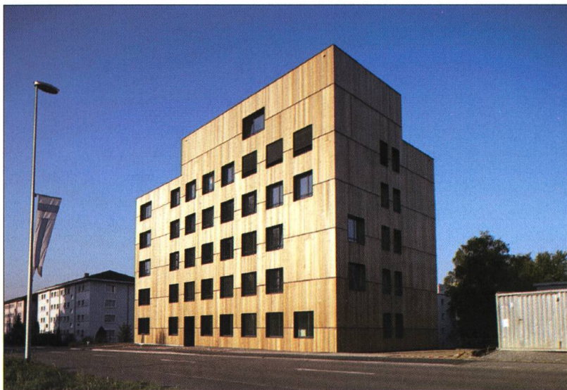
Cet immeuble à Steinhäusen, dans le canton de Zoug, est le premier bâtiment de six niveaux réalisé intégralement en bois. Photo Renggli AG, Sursee
