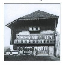
Dans l'architecture régionale en bois, l'épicéa est le matériau dominant. Le chêne est réservé à la sablière, qui repose sur les fondations en maçonnerie, et à l'encadrement de la porte de la grange. Il est aussi fréquemment utilisé pour la porte d'entrée de l'habitation, plus rarement pour des portes intérieures. Au-dessus du poêle, le mur peut être habillé d'une boiserie en chêne, en noyer ou en cerisier.
