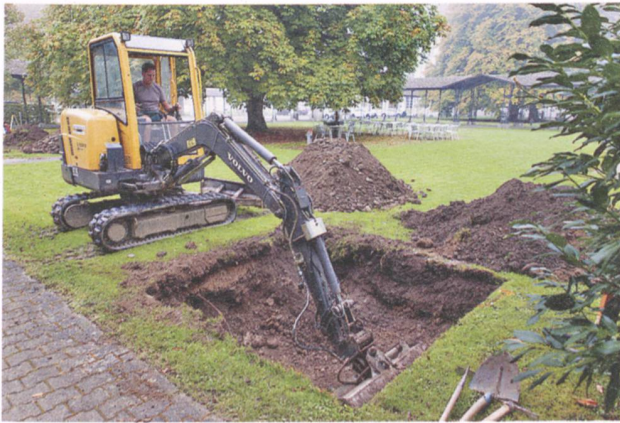
Abb. 15: Windisch-Königsfelden 2014 (V.014.7). Anlegen eines Sondageschnitts mit dem Kleinbagger im Park nördlich des 1868–72 gebauten Hauptgebäudes.
