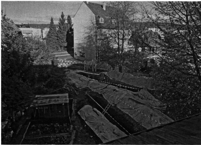
Abb. 10: Windisch-Zürcherstrasse: Übersicht mit den Sondiergräben (von Südwesten).
