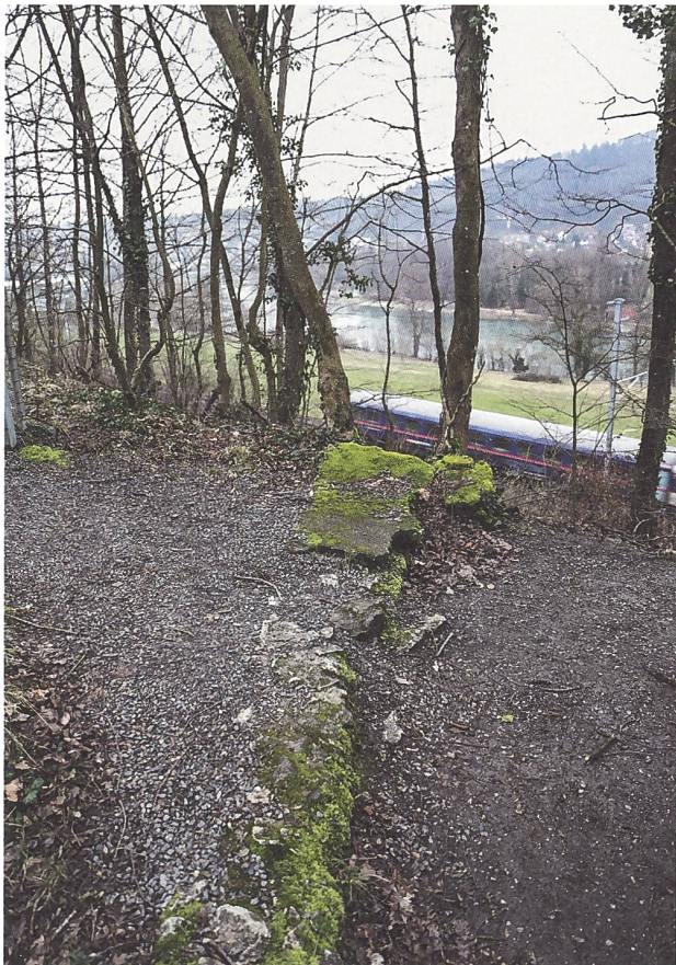
Abb. 8: Monitoring Ruinenstätten 2024 (V024.202). Heutige Aufnahme des nordwestlichen Endes des Mauerabschnitts von 1897 an der Abbruchkante zur Aareniederung. Deutlich zeigt sich der Verlust grosser Teile der Mörtelabdeckung und der teilweise erfolgte Verlust der 1903 konservierten feindseitig orientierten Mauerschale.
