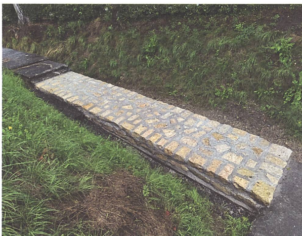
Abb. 4: Windisch-Amphitheater (V.024.80). Die rekonstruierte Mauerkrone von Mauer 20 von Südwest nach Nordost. Deutlich zeichnet sich durch die Farbgebung des Baumaterials die neue Überhöhung der möglichen «Opferschicht» gegenüber dem Bestand des sanierten Mauerwerks ab.
