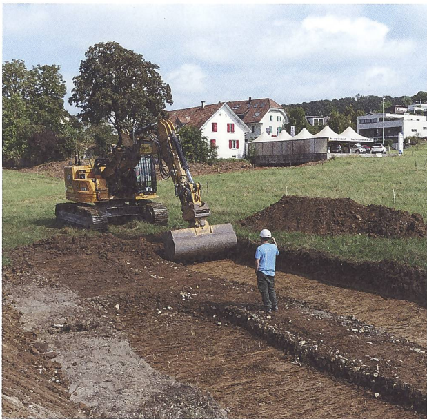
Abb. 7: Grabungstechniker Benedikt Wyss kontrolliert den maschinellen Oberbodenabtrag im Bereich der «toten» römischen Wasserleitung von Vindonissa (Meldung Nr. 19).
