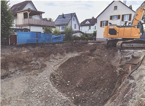
Abb. 21: Windisch-Birkenstrasse 2024 (V.024.6). Arbeitsfoto von Nordwesten auf die laufenden Aushubarbeiten. Die Baugrubenwand im Hintergrund zeigt im anstehenden grauen Kies des C-Horizonts mehrere grubenartige, mit verlehmtm Kies verfüllte Strukturen, die geologischer Natur sind.
