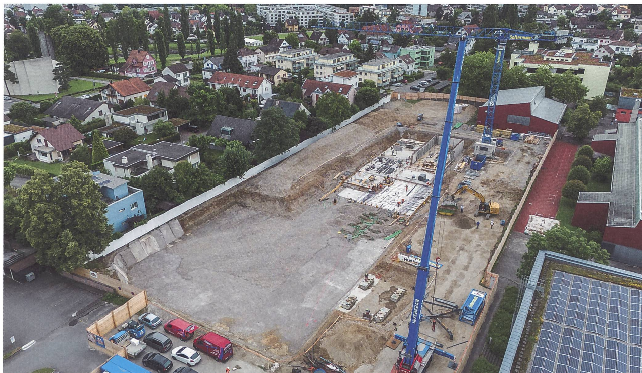
Abb. 19: Windisch-Dohlenzelgshulhaus 2024 (V.024.2). Drohnenfoto von Süden mit der fertig ausgehobenen Baugrube für das neue Schulhaus. Im Hintergrund links die Pappeln mit dem römischen Amphitheater.
