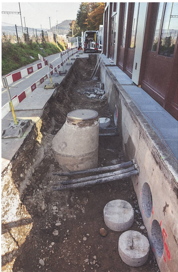
Abb. 17: Windisch-Königsfelden (Park) 2024 (V.024.9): Arbeitsfoto von Westen in den Werkleitungsgraben zwischen Bahndamm (links) und Nordfassade des Betriebsgebäudes der Klinik Königsfelden (rechts). Die Bäume im Hintergrund stehen am Nordhang des «Schutthügels» des Legionslagers.
