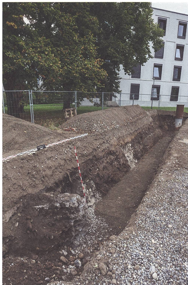
Abb. 16: Windisch-Königsfelden (Park) 2024 (V.024.9): Arbeitsfoto von Nordwesten mit Blick auf das Ostprofil des Werkleitungsgrabens beim Grundwasserschacht. Betonierter Schacht (Vordergrund), Fundament der neuzeitlichen Klinikgartenmauer im Grabenprofil (Mittelgrund) und Nordwestfassade des neuen Klinikhauptgebäudes (Hintergrund).
