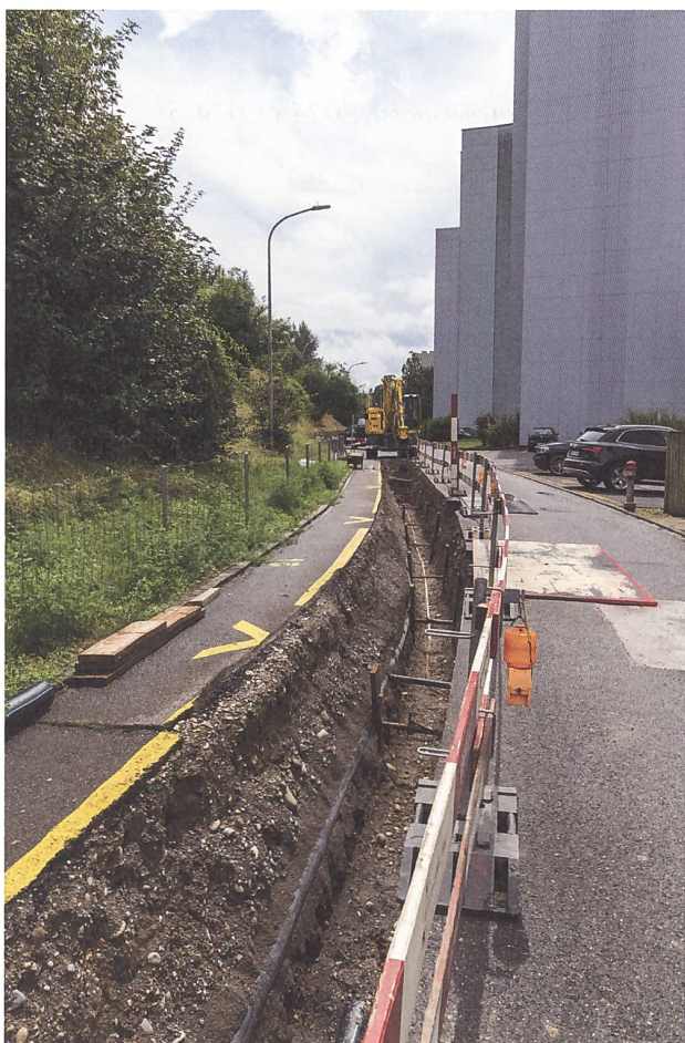
Abb. 12: Brugg-Hafnerweg 2024 (Bru.024.2). Blick von Norden auf die Werkleitungsgräben am Fuss des SBB-Bahndamms (links), knapp 175 m südöstlich des spät römischen Kastells Brugg-Altenburg. In den Grabenprofilen sind nur anstehende, kiesig-sandige Schichten angeschnitten.
