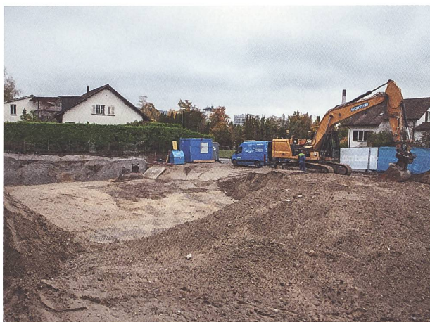
Abb. 18: Windisch-Reutenenstrasse 2024 (V.024.8). Blick von Südwesten auf die grösstenteils fertig ausgehobene Baugrube mit anstehenden Kiesen und Sanden. Südlich des Hauses im Hintergrund rechts wurden 1999 neuzeitliche Gräber entdeckt.
