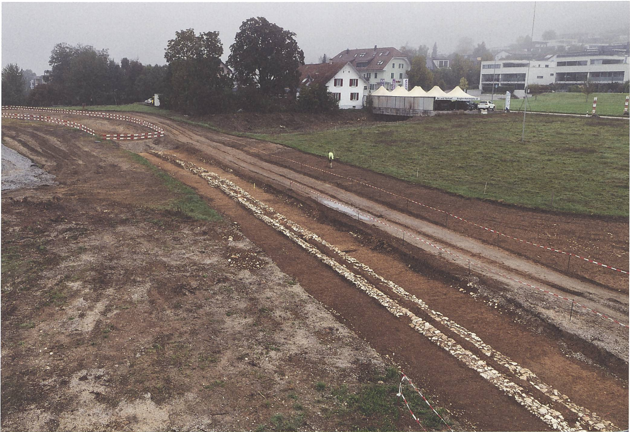
Abb. 32: Hausen-Reichholdareal 2024–2025 (Hus.024.1). Blick von Südwesten auf die Grossbaustelle mit einem freigelegten Abschnitt der nicht mehr Wasser führenden Leitung von Vindonissa.
