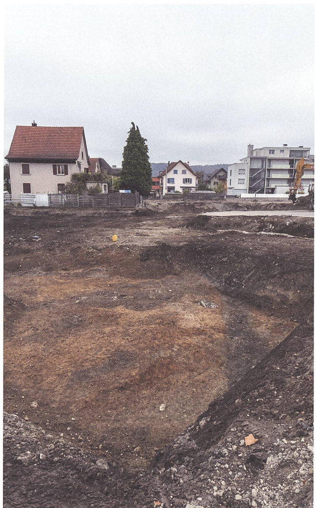
Abb. 23: Windisch-Zürcherstrasse 2024 (V.024.10). Blick von Westen auf den Bauplatz nach erfolgtem Abbruch des Bestands und anschliessendem Oberbodenabtrag. Im Vordergrund zeichnen sich unter einem abgebauten Kellerboden die Reste der ältesten römischen Holzbauperioden und eines jüngeren Spitzgrabens (rechts) ab.
