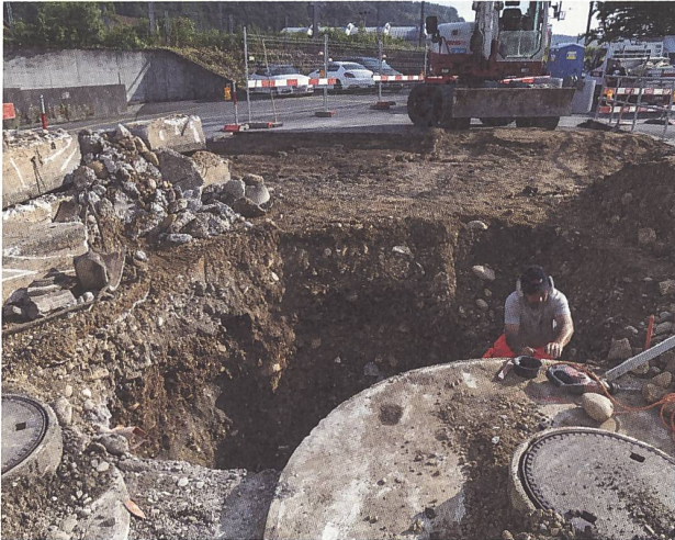
Abb. 14: Windisch-Zürcherstrasse 2024 (V.024.5). Arbeitsfoto von Südwesten auf die laufenden Aushubarbeiten. Unter modernen Planien ist überall der anstehende glaziale Schotter angeschnitten. Im Hintergrund der Bahndamm der SBB-Linie Brugg-Baden.
