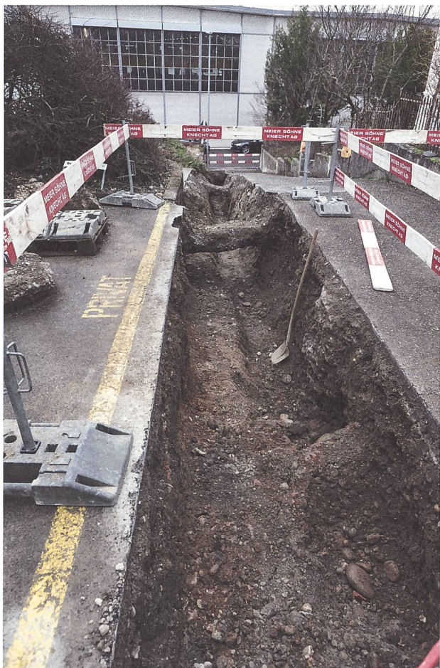
Abb. 13: Windisch-Klosterzelg 2022–2024 (V.022.4). Blick von Süden in den Werkleitungsgraben im nördlichen Abschnitt des Florasteigs, der hier eine markante Terrassenstufe schneidet. Trotz der Nähe zu einem 1906 beobachteten Kalkbrennofen sind in diesem Aufschluss keinerlei archäologische Strukturen vorhanden.
