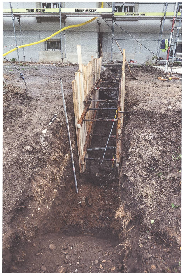
Abb. 15: Windisch-Königsfelden (Hauptgebäude) 2024 (V.024.7). Ansicht von Südosten in den Werkleitungsgraben vor der Südwestfront des alten Klinikhauptbaus. Im vorderen, noch nicht verspriessten Westprofil ist knapp 1,2 m unter aktuellem Terrain der Rest eines Gartenmauerfundaments als helle Planierungsschicht erkennbar.
