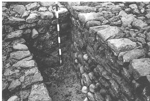
Abb. 5: Oberentfelden AG-Büntlis. Fundament mit Bollensteinen und aufgehendes Mauerwerk der Steinbauperiode des späten 1. bis späten 3. Jh. in Haus 18. – Auch bei anderen Häusern der pars rustica waren gelegentlich Lagen von gleichartigem Aufgehendem erhalten (Fotoalbum 1938, Nr. 169).
