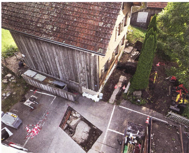
Abb. 16: Filzbach GL, Vordemwald. Blick auf die drei Sondierschnitte im Bereich des «Hauses Menzi» (Liegenschaft Kerenzerbergstrasse 102). Ganz links im Bild die 1960 restaurierte NW-Ecke des frühromischen Turms, in der Bildmitte der anstehende Felsen mit der SW-Ecke des Turms und im Hintergrund die SO-Ecke des Turms.
