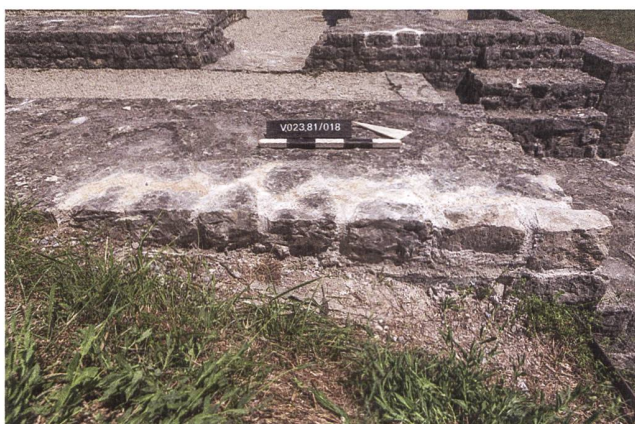
Abb. 17: Windisch-Amphitheater (V.023.80). Typische Ausbesserungen an den Mauerkronen bis hin zum Ersatz ganzer Handquader.
