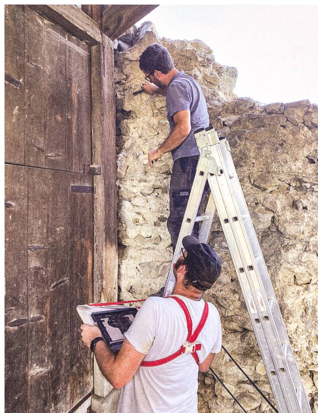
Abb. 9: Brugg-Altenburg (Bru.023.80). Martin Gantner (ProSpect GmbH) und Sascha Döring (Maurerhandwerk Döring) bei der Schadenskartierung an der Westseite der Kastellmauer.
