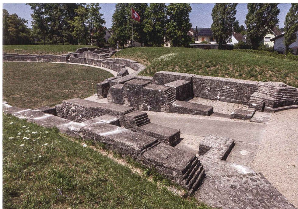
Abb. 16: Windisch-Amphitheater (V.023.81). Übersichtsfoto des östlichen Eingangs. Gut sichtbar sind die weissen Ausbesserungs- stellen am Mauerwerk.
