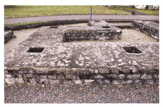
Abb. 19: Legionärspfad Vindonissa (V.023.200). Das Nordtor. Typisches Schadbild mit Rissbildung unter den Mauerkronenabdeckungen aus Mörtel und im Hintergrund Ausbruchstellen an der Mauerkrone.
