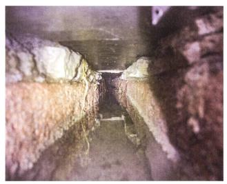
Abb. 14: Windisch-Wagnerhof (V.023.80). Blick in die römisch-mittelalterliche Wasserleitung vor dem Einsatz des Fräsroboters. Wurzeln ragen von der Decke in den Wasserkanal.
