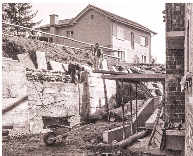
Abb. 12: Windisch-Anemonenstrasse 1968. Sicherungsmassnahmen an der römisch-mittelalterlichen Wasserleitung durch eine Betonstützkonstruktion.
