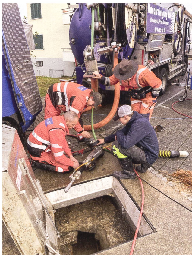
Abb. 4: Römisch-mittelalterliche Wasserleitung (V.023.80). Mitarbeitende der Firmen DrainJet und Kanalreinigung Näf bereiten das Gefährt mit Kanal-TV und Hochdruckdüse für den Einsatz in der Wasserleitung vor.
