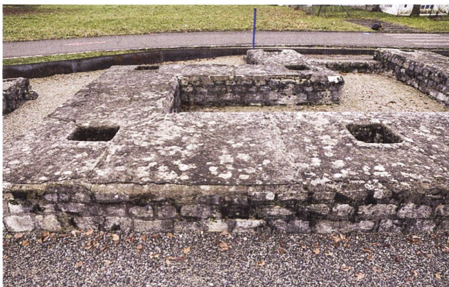
Abb. 19: Legionärspfad Vindonissa (V.023.200). Das Nordtor. Typisches Schadbild mit Rissbildung unter den Mauerkrönenabdeckungen aus Mörtel und im Hintergrund Ausbruchstellen an der Mauerkrone.
