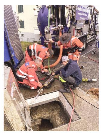
Abb. 4: Römisch-mittelalterliche Wasserleitung (V.023.80). Mitarbeitende der Firmen DrainJet und Kanalreinigung Näf bereiten das Gefährt mit Kanal-TV und Hochdruckdüse für den Einsatz in der Wasserleitung vor.
