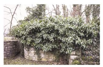
Abb. 22: Legionärspfad Vindonissa (V.023.200). Der sog. Bühlturm. Gegenwärtiger Zustand mit starkem Efeubewuchs.
