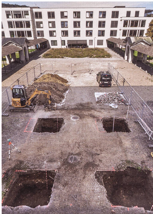
Abb. 18: Windisch-Königsfelden Park 2023 (V.023.10). Blick von Süden auf die vier Baugruben für Kranfundamente im Innenhof des alten Hauptgebäudes der Klinik Königsfelden. Im Hintergrund der 2017–2020 erstellte Neubau «Magnolia».
