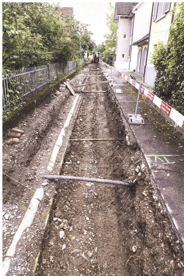
Abb. 19: Windisch-Klosterzelg 2022–2023 (V.022.4). Blick von Norden in den Werkleitungsgraben im nördlichen und mittleren Abschnitt des Gartensteigs, mit bestehenden Werkleitungen und Hausanschlüssen. In diesem Areal ca. 480 m südwestlich des römischen Legionslagers sind keinerlei archäologische Strukturen vorhanden.
