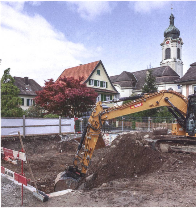
Abb. 28: Brugg-Bahnhofstrasse 2022 (Bru.022.4). Arbeitsfoto von Südosten auf die laufenden Aushubarbeiten nach Abbruch der Altliegenschaft. Im Hintergrund rechts die katholische Stadtkirche von Brugg, die 1907 eingeweiht wurde.
