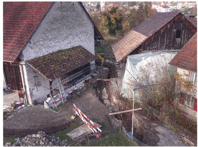
Abb. 9: Brugg-Altenburg 2022 (Bru.022.7). Drohnfoto von Südosten mit dem Werkleitungsgraben am Osteingang der spätromischen Befestigung. Im Hintergrund in der Mitte die Dorfkirche von Umiken jenseits, d. h. nördlich der Aare.
