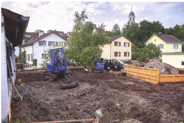
Abb. 21: Windisch-Bühlweg 2022 (V.022.5). Blick von Nordosten auf die laufenden Baggerarbeiten mit der Dorfkirche von Windisch oben auf dem Plateau (Hintergrund rechts).
