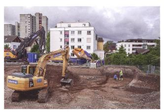
Abb. 27: Brugg-Wildenrainweg 2022 (Bru.022.3). Arbeitsfoto von Osten zur westlichen Baugrubenwand. Über dem anstehenden gelben Silt liegt eine neuzeitliche Humusschicht, gefolgt von einer bis zu 2 m starken modernen Aufschüttung.
