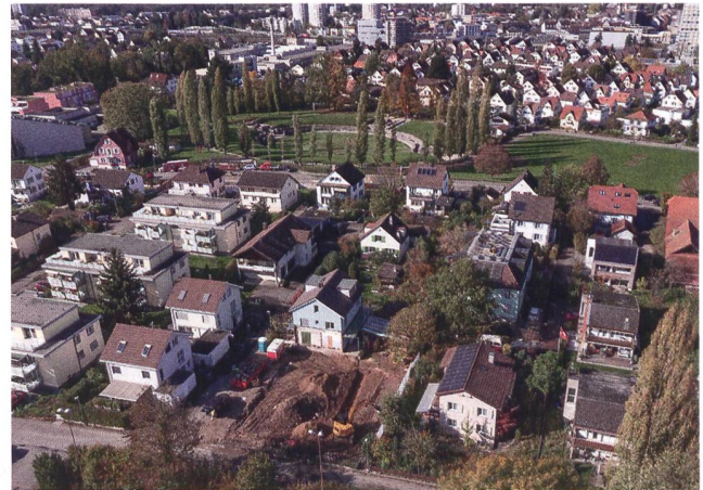
Abb. 20: Windisch-Buchenweg 2022 (V.022.7). Drohnensfoto von Südosten mit der laufenden Baustelle (vorne Mitte) und dem römischen Amphitheater von Vindonissa (Hintergrund).
