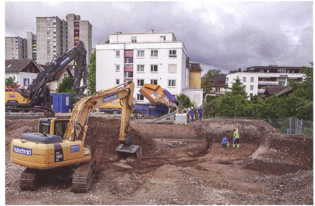
Abb. 27: Brugg-Wildenrainweg 2022 (Bru.022.3). Arbeitsfoto von Osten zur westlichen Baugrubenwand. Über dem anstehenden gelben Silt liegt eine neuzeitliche Humusschicht, gefolgt von einer bis zu 2 m starken modernen Aufschüttung.
