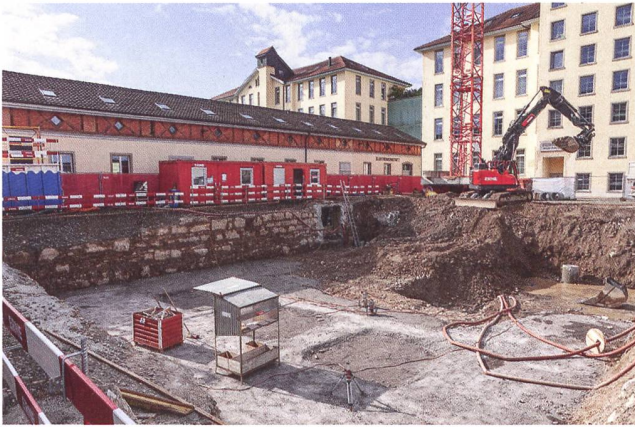
Abb. 22: Windisch-Unterwindisch (Kunzareal) 2022 (V.022.9). Arbeitsfoto von Nordosten mit den Aushubarbeiten im Bereich des ehemaligen Kesselhauses. In der gegenüberliegenden Baugrubenwand sind noch Reste der historischen Uferschutzmauer vorhanden.
