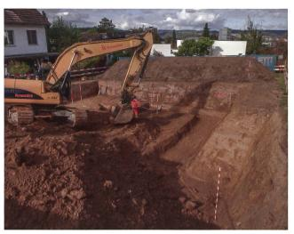
Abb. 16: Windisch-Chapfstrasse 2021 (V.021.9). Blick von Osten auf die laufenden Aushubarbeiten mit mächtigen Schwemmlehmschichten in den Baugrubenwänden.
