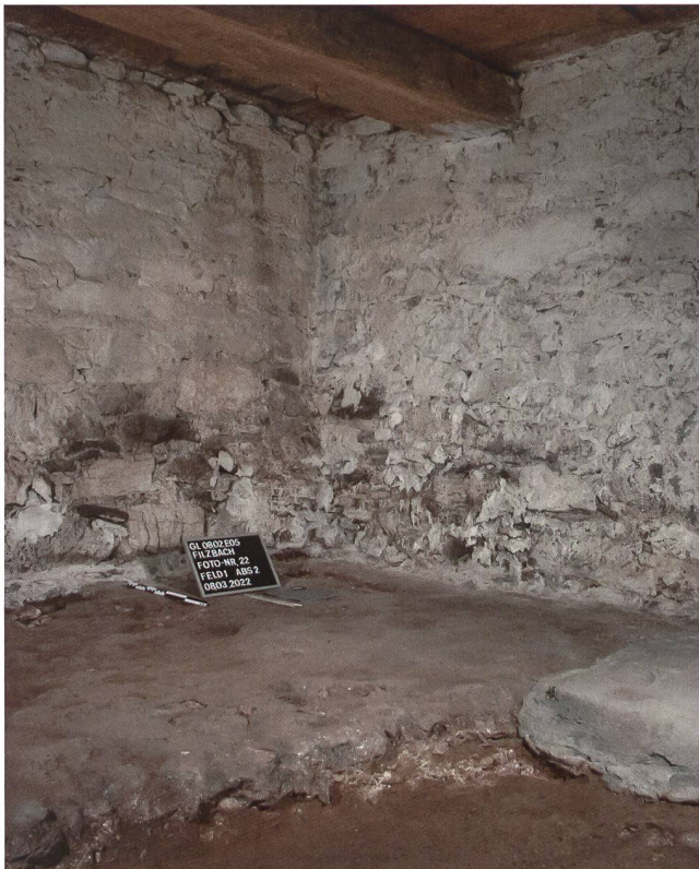
Abb. 10: Wachturm Filzbach (GL), Vordemwald. Blick auf die freigelegten Überreste des spätrepublikanischen/frühaugusteischen Mörtelgussbodens im Keller des «Hauses Menzi» (heute Liegenschaft Kerenzbergstrasse 102).
