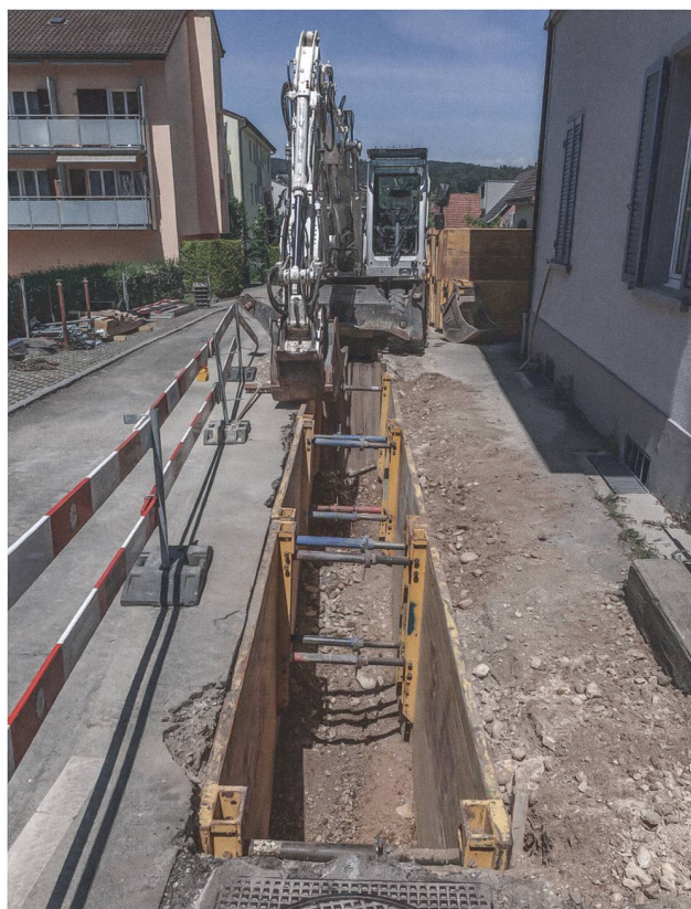
Abb. 31: Brugg-Blumenstrasse 2020 (Bru.020.2). Blick von Südosten auf die Einmündung der Blumenstrasse in die Aarauerstrasse in einen bereits verspriessten Werkleitungsgraben.
