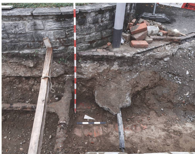
Abb. 11: Windisch-Klosterzelg 2017–2020 (V.017.2). Blick von Osten in einen Abschnitt des Werkleitungsgrabens in der Reutenenstrasse. Unter der modernen Wasser- und Kandelaberleitung sind auf der Grabensohle die vermörtelten Kalksteine vom Unterbau einer älteren Tonröhrenleitung angeschnitten.
