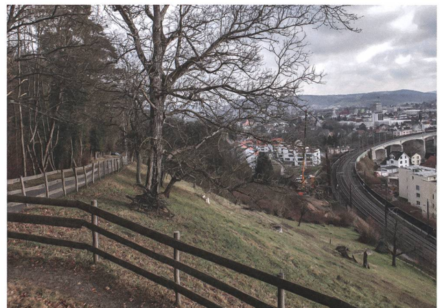
Abb. 29: Umiken-Chilhalden 2020 (Umi.020.1). Überblick von Nordwest auf die Baustelle (mit orangem Pneukran) zwischen Bruggerberg und SBB-Bahnlinie Brugg-Basel. Im Vordergrund links die heutige Rinikerstrasse, hier identisch mit dem Verlauf der alten, wohl bis in römische Zeit zurückreichenden Bözbergstrasse.
