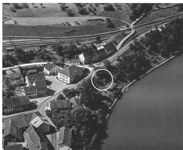
Abb. 16: Stein AG. Im Jahr 1956 angefertigte Luftbildaufnahme des mittelalterlichen Dorfkerns (Blick von Osten). Die beiden Pfeile markieren die vermuteten Standorte der spätantiken Wachtürme Mumpf-Ob dem Dorf und Stein-Dorfkern (oben). Im Jahr 1950 angefertigte Luftbildaufnahme der Rheinhalde im Bereich des «Steinerstichs». Der nicht mehr genau lokalisierbare Wachturm Stein-Dorfkern stand wahrscheinlich zwischen der Strassenverzweigung und dem im 2. Weltkrieg gebauten Bunker (unten).
