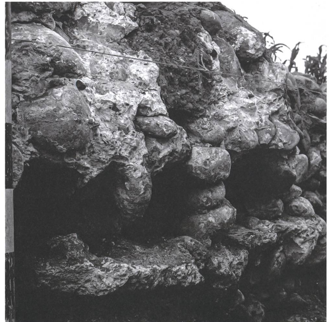
Abb. 22: Sisseln AG, Hintere Halde (1972). Nicht mehr lokalisierbare Detailaufnahme der aus mit grossen Kieselwacken durchsetztem opus caementitium bestehenden Fundamente der Nord- oder Südmauer des Mitteltrakts der spätantiken «Magazinstation». Gut zu erkennen sind die beim Verrotten der Holzarmierung entstandenen Hohlräume.
