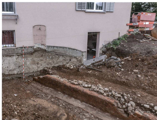
Abb. 33: Windisch-Oelackerstrasse 2019 (V.019.5). Blick von Südwesten auf die freigelegten Abschnitte der «toten» römischen Wasserleitung, die hier von der Ecke eines 1951 gebauten EFH überlagert wird.
