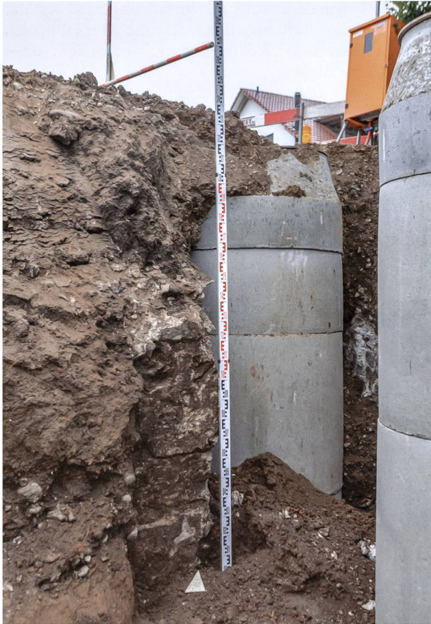
Abb. 9 Windisch-Dorfstrasse (Huber) 2018–2019 (V.018.2). Blick von Südwesten auf die Baugrube für einen Schachteinbau an der Dorfstrasse. Der neue Schacht durchschneidet das fast 2 m hoch erhaltene Fundament der «Apsidenbau»-Nordmauer mit Negativabdrücken der ehemaligen Baugrubenverschalung.
