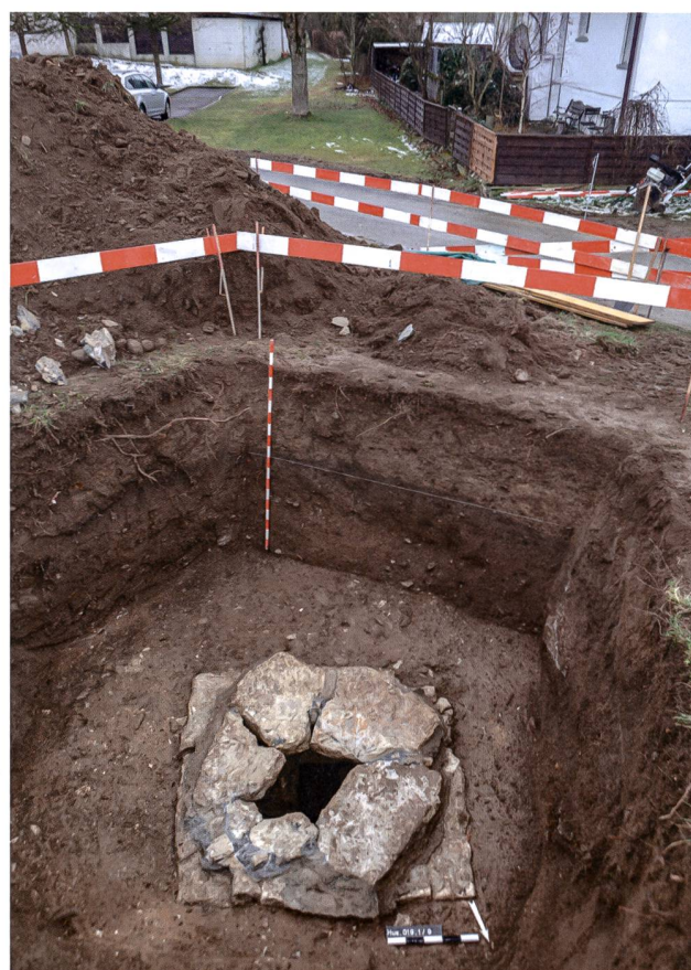
Abb. 32: Hausen-Feuerwehrmagazin 2019 (Hus.019.1). Blick von Norden auf die Baggersondage mit dem freigelegten und bereits teilweise geöffneten «Schacht 16» der Wasser führenden Leitung. Die unterirdische Leitungstrasse verläuft weiter nach Süden unter der im Hintergrund sichtbaren Parzellengrenze.
