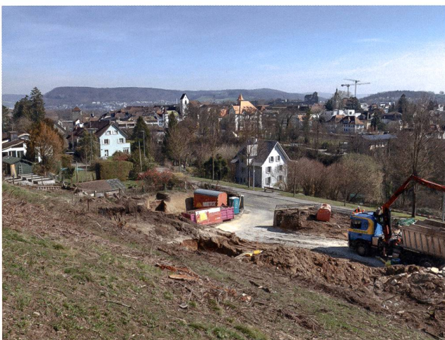
Abb. 29: Brugg-Baslerstrasse 2018–2019 (Bru.018.5). Blick von Nordwesten auf die laufenden Abbrucharbeiten in der Parzelle am Bruggerberg. Am linken oberen Bildrand das Areal des römischen Gräberfelds am «Remigersteig».
