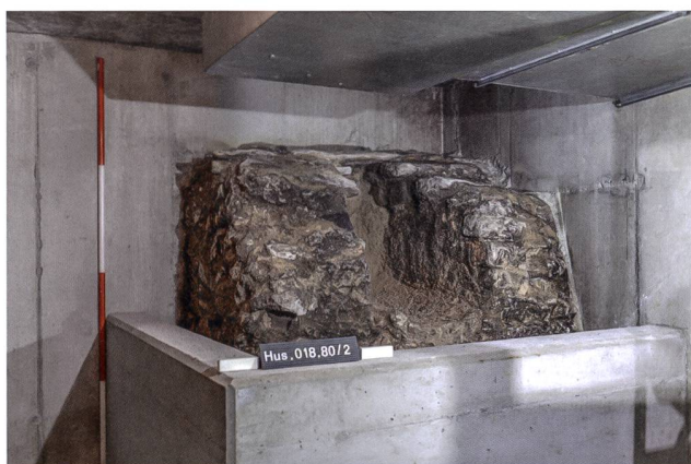
Abb. 34: Hausen-Hauptstrasse 2018-2019 (Hus.018.80). Das 1990 konservierte Teilstück der «toten» römischen Wasserleitung, 2019 gereinigt und mit einer neu gesetzten Trennmauer vor parkierenden Autos leidlich geschützt.
