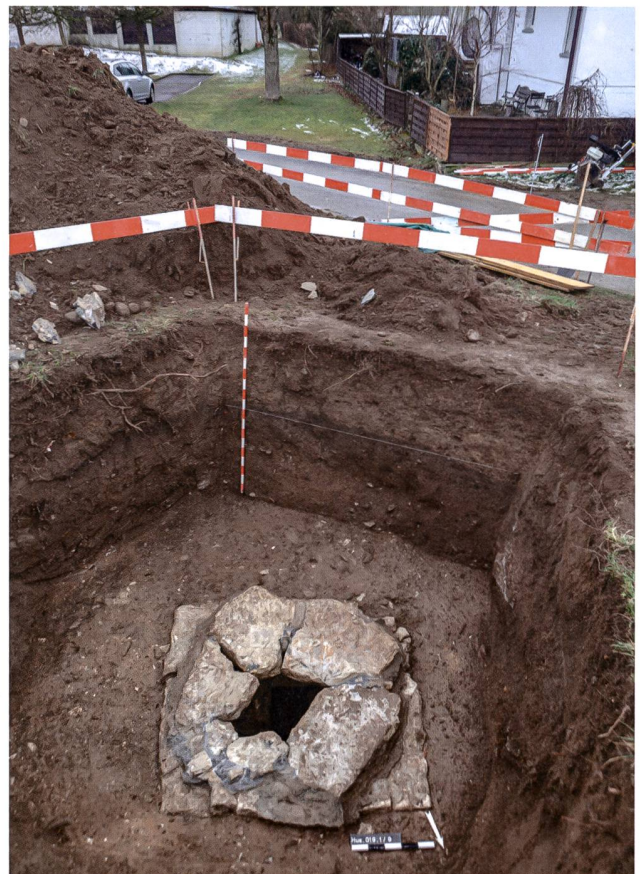
Abb. 32: Hausen-Feuerwehrmagazin 2019 (Hus.019.1). Blick von Norden auf die Baggersondage mit dem freigelegten und bereits teilweise geöffneten «Schacht 16» der Wasser führenden Leitung. Die unterirdische Leitungstrasse verläuft weiter nach Süden unter der im Hintergrund sichtbaren Parzellengrenze.
