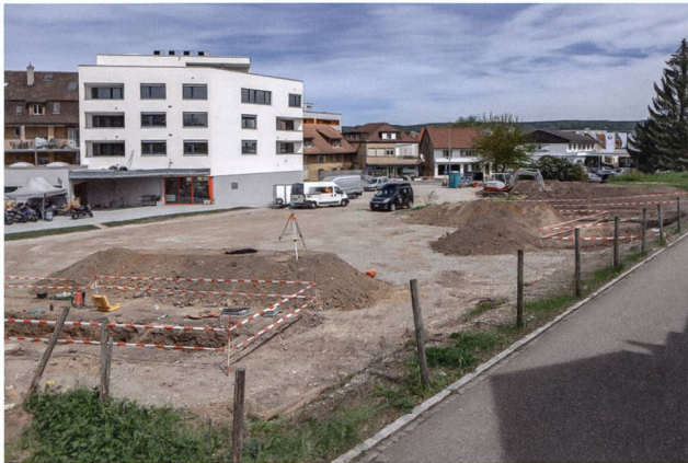
Abb. 24: Windisch-Zürcherstrasse 2019 (V.019.3). Blick von Südwesten auf das sondierte Areal mit dem Sonnenweg im Vordergrund. Der mehrgeschossige Neubau links war Anlass der archäologischen Grabungen 2016–2018. Das ältere Haus mit Walmdach im Hintergrund steht auf einem Spitzgraben des römischen Legionslagers.
