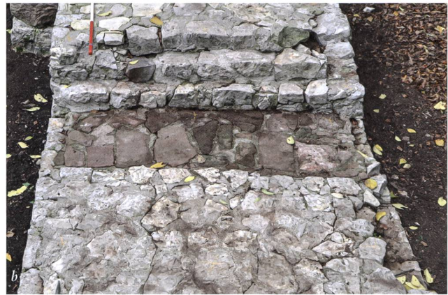
Abb. 12: Wällbach-Stelli (Wäl.015.1/Wäl.019.80). Blick von Südwesten (a) und Norden (b) auf den Eingangsbereich der Kleinfestung (Zustand vor der Sanierung im Jahr 2019). Die ausgeplünderten Schwellsteine im Bereich des Eingangs wurden bei der Restaurierung (1955) mithilfe von kleineren Spolien aus rotem Sandstein markiert.
