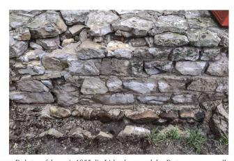
Abb. 15: Wallbach-Stelli (Wal. 015. 1/Wal. 019. 80). Blick auf das 2019 entfernte Podest, auf dem seit 1955 die Lichtscharte und das Postament ausgestellt waren (a). Blick auf die Aussenschale der Ostmauer (b). Gut zu erkennen ist der Absatz zwischen der hervorragend erhaltenen Fundamentzone und der 1955 teilweise neu aufgemauerten Mauerschale (Zustand vor der Sanierung).
