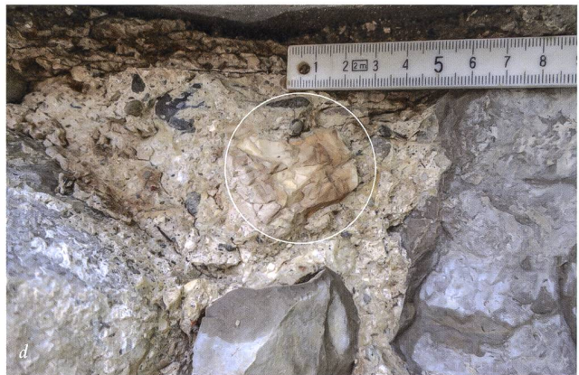
Abb. 14: Wällbach-Stelli (Wal.015.1/Wal.019.80). Ansicht der inneren Mauerschale der Nordmauer; unter der horizontalen Linie liegende Parteien sind antik (a). Die mit hellbraunem Lösslehm verschmutzte Zone im opus caementitium des Mauerkerne (b) könnte auf einen saisonalen Bauunterbruch hindeuten. Ansicht der vornehmlich aus Muschelkalkquadern bestehenden inneren Mauerschale der Westmauer; unter der horizontalen Linie liegende Parteien sind antik (c). Der schräg gestellte Kalksteinquader in der Bildmitte und die unterschiedliche Höhe der Steinlagen lassen vermuten, dass sich hier die Schnittstelle zwischen zwei Baulosen befand. Detailaufnahme des opus caementitium im Bereich der Innenschale der Südmauer (d). Im beige Kalkmörtel ist ein unvollständig gebrannter Kalkstein zu erkennen.
