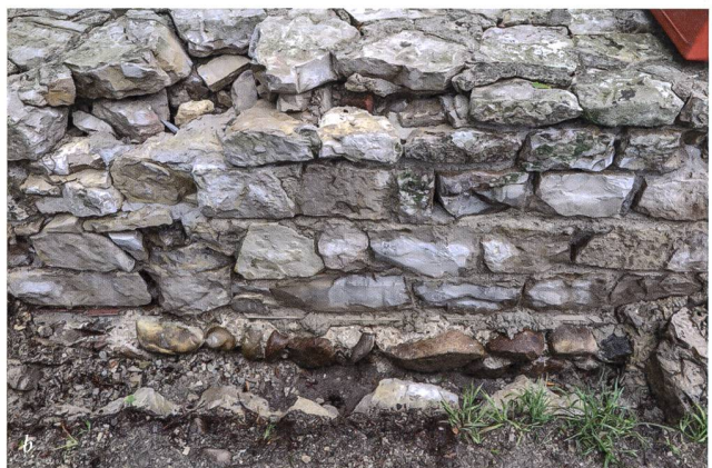
Abb. 15: Wällbach-Stelli (Wal.015.1/Wal.019.80). Blick auf das 2019 entfernte Podest, auf dem seit 1955 die Lichtscharte und das Postament ausgestellt waren (a). Blick auf die Aussenschale der Ostmauer (b). Gut zu erkennen ist der Absatz zwischen der hervorragend erhaltenen Fundamentzone und der 1955 teilweise neu aufgemauerten Mauerchale (Zustand vor der Sanierung).
