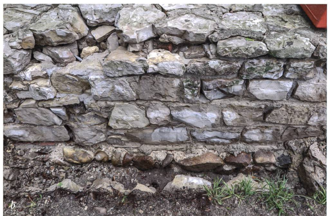
Abb. 15: Wallbach-Stelli (Wal.015.1/Wal.019.80). Blick auf das 2019 entfernte Podest, auf dem seit 1955 die Lichtscharte und das Postament ausgestellt waren (a). Blick auf die Aussenschale der Ostmauer (b). Gut zu erkennen ist der Absatz zwischen der hervorragend erhaltenen Fundamentzone und der 1955 teilweise neu aufgemauerten Mauerschale (Zustand vor der Sanierung).
