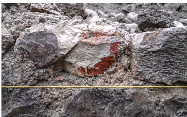
Abb. 29: Baden-Dependance Ochsen 2009–2010 (B.009.5). Durch das Schadfeuer geröteter und abgeplatzter Kalkstein der Mauer M12.
