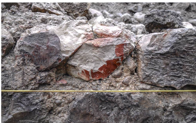
Abb. 29: Baden-Dependance Ochsens 2009–2010 (B.009.5). Durch das Schadfeuer geröteter und abgeplatzter Kalkstein der Mauer M12.
