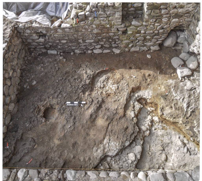
Abb. 13: Baden-Dependance Ochsens 2009–2010 (B.009.5). Mauer M19 mit drei Aussparungen für die Balkenlager. Die rechte Aussparung wurde beim Abbruch ausgerissen. Darüber die Reste der Nischen. Blickrichtung Südwesten.
