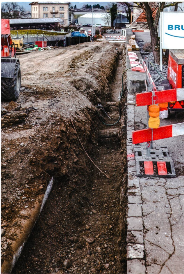
Abb. 18: Windisch-Klosterzelg 2017–2018 (V.017.2). Werkleitungsarbeiten zwischen Unterer Klosterzelgstrasse und Bachmattstrasse. Mehr als eng begrenzte Einblicke in den frisch ausgehobenen Leitungsraben sind bei solchen Baubegleitungen in der Regel kaum möglich.
