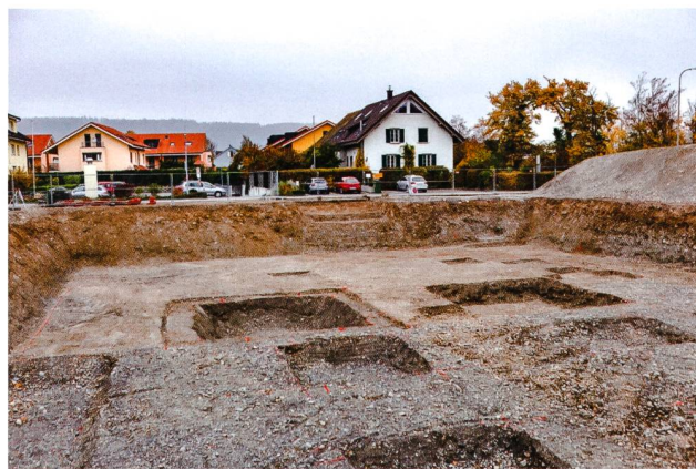
Abb. 32: Windisch-Am Rain 2018 (V.018.5). Blick von Südwesten auf die vollständig ausgehobene Baugrube mit der nördlichen Baugrubenwand und der natürlichen Schichtabfolge der Hochterrasse. Das ältere Haus rechts im Mittelgrund steht im Bereich einer spätrömischen Körpergräber-Gruppe.
