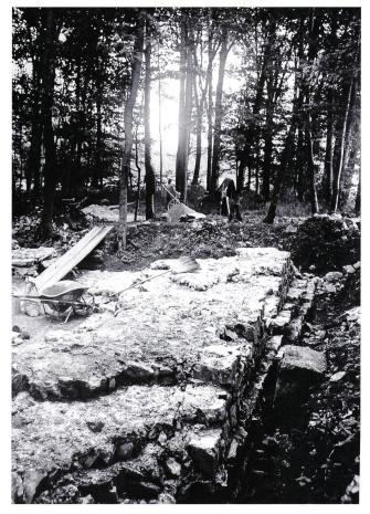
Abb. 14: Rheinfelden-Pferrichgraben (Grabung/Restaurierung 1938). Blick aus dem Turminnern an die Innenschale der Nordmauer vor Beginn der Freilegungsarbeiten (a) auf den freigelegten Nordabschnitt der Westmauer (b). Gut zu erkennen ist das kompakte Gussmauerwerk (opus caementitium) im Mauerkern und dass die Flucht des aufgehenden Mauerwerks (links) deutlich von derjenigen des Fundaments abweicht (vgl. dazu auch Abb. 12).
