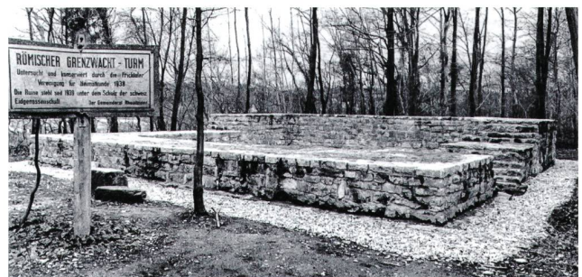
Abb. 19: Rheinfelden-Pferrichgraben (Sanierung 1974). Zustandsaufnahme nach Abschluss der Sanierungsarbeiten. Der Wortlaut auf der Informationstafel lautet: «Römischer Grenzwachturm. Untersucht und konserviert durch die Fricktal. Vereinigung für Heimatkunde 1938. Die Ruine steht seit 1939 unter dem Schutze der Schweiz. Eidgenossenschaft. Der Gemeinderat Rheinfelden» (vgl. dazu auch Anm. 95). Beim Betonpfeiler sind auch die bei den früheren Untersuchungen entdeckten Architekturelemente aus Buntsandstein zu erkennen.
