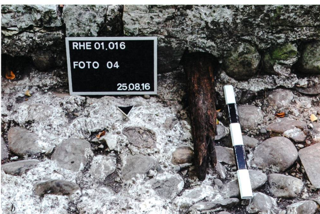
Abb. 24: Rheinfelden-Pferrichgraben 2016–2017 (Rhe 016.1). Blick von Osten auf die OK des opus caementitium im Bereich des Eingangs (a). Detailaufnahme des Übergangsbereichs zwischen dem Fundament und dem Aufgehenden der Ostmauer (b). Eines der seinerzeit (1938) aus didaktischen Gründen in die Hohlräume der Balkenarmierung eingesetzten Rundhölzer war noch erhalten.
