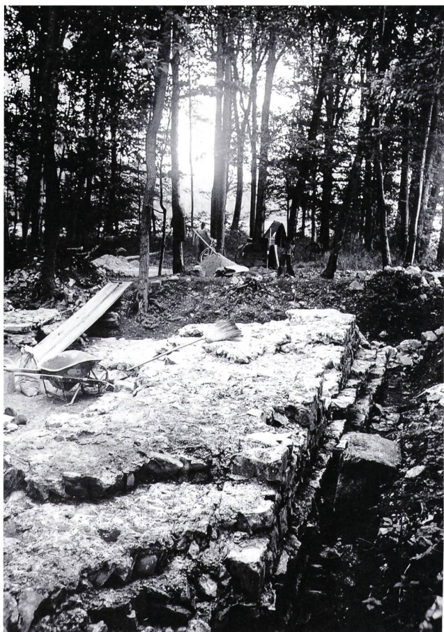
Abb. 14: Rheinfelden-Pferrichgraben (Grabung/Restaurierung 1938). Blick aus dem Turminnern an die Innenschale der Nordmauer vor Beginn der Freilegungsarbeiten (a) auf den freigelegten Nordabschnitt der Westmauer (b). Gut zu erkennen ist das kompakte Gussmauerwerk ( opus caementitium ) im Mauerkerne und dass die Flucht des aufgehenden Mauerwerks (links) deutlich von derjenigen des Fundaments abweicht (vgl. dazu auch Abb. 12).
