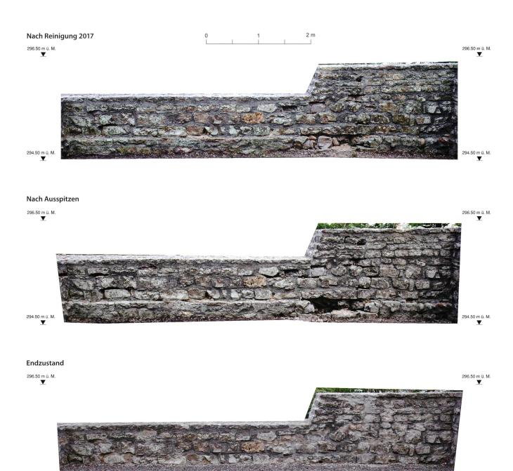
Abb. 20: Rheinfelden-Pferrichgraben 2016–2017 (Rhe.016.1). Zustand der Innenschale der Westmauer nach der Reinigung des Mauerwerks, nach dem Ausspitzen der Schadstellen und nach Abschluss der Sanierung im September 2017.
