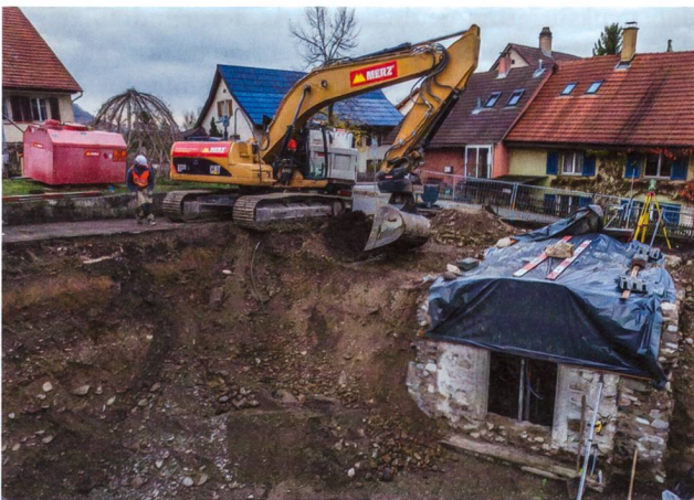
Abb. 27: Windisch-Ländestrasse 2017 (V.017.8). Blick von Südwesten auf die Baugrube nach Abriss von Haus Ländestrasse 2. Rechts im Bild stehen gebliebene Gewölbekeller aus dem frühen 19. Jh. Das Baugrubenprofil links zeigt geologische Schichten unter neuzeitlichen Planien.
