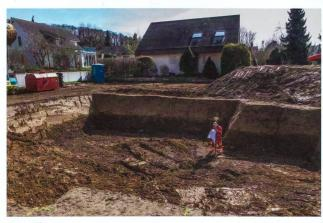
Abb. 34: Hausen-Birkenstrasse 2016–2017 (Hus.016.2). Blick von Nordwesten auf die fertig ausgehobene Baugrube während der Einmessung mit dem Trimble. Die Baugrubenwände zeigen die natürliche Schichtabfolge mit einer mächtigen Schwemmlehm-Auflage am Fusse des Lindhofhügels.
