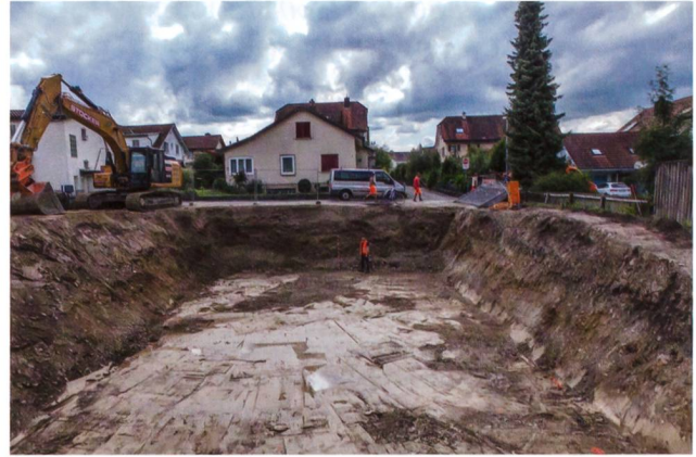
Abb. 19: Windisch-Neumattstrasse 2017 (V.017.7). Blick von Osten auf die fertig ausgehobene Baugrube in Parzelle Nr. 2398 an der Neumattstrasse. Unter dem umgelagerten Humus folgen anstehende Kies- und Lehmschichten.
