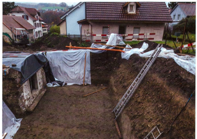
Abb. 28: Windisch-Ländestrasse 2017 (V.017.8). Blick von Norden auf die Baugrube nach Abriss von Haus Ländestrasse 2. Links der stehen gebliebene Gewölbekeller aus dem frühen 19. Jh. Die geputzten Baugrubenprofile zeigen geologische Schichten unter neuzeitlichen Planien.
