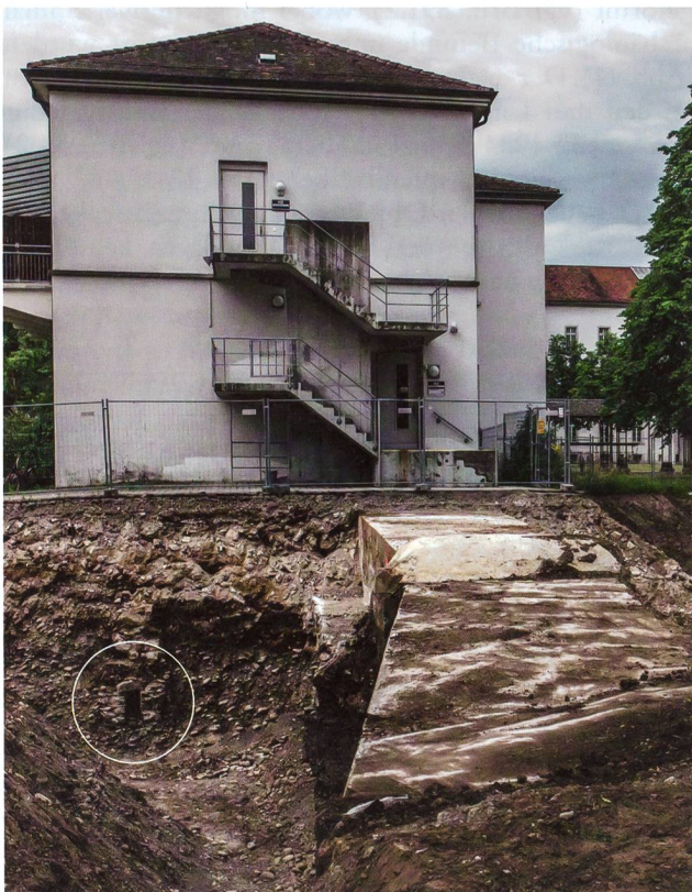
Abb. 13: Windisch-Königsfelden (Park) 2016–2017 (V.016.2). Klinik mit Geschichte: Blick von Norden auf den Nordostflügel des Klinikhauptgebäudes Königsfelden (erbaut 1868–1872). Davor bzw. in das Gebäude hinein verläuft ein unterirdischer Versorgungstunnel aus den 1960er-Jahren. Links unten (Kreis) in der Baugrubenwand der wiederentdeckte Abwasserkanal aus dem Spätmittelalter bzw. der frühen Neuzeit, der von den Fundamenten eines 1976 abgerissenen Flügelbaus der Klinik überlagert wird.
