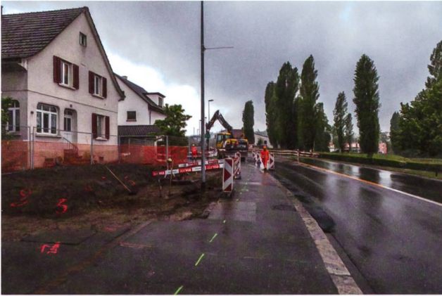
Abb. 18: Windisch-Hauserstrasse 2017 (V.017.4). Blick von Nordosten auf die Baustelle der Lärmschutzwand entlang der Hauserstrasse. Im Hintergrund rechts das von hohen Pappeln gesäumte Amphitheater von Vindonissa.
