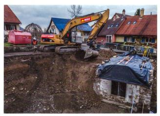
Abb. 27: Windisch-Ländestrasse 2017 (V.017.8). Blick von Südwesten auf die Baugrube nach Abriss von Haus Ländestrasse 2. Rechts im Bild der stehen gebliebene Gewölbekeller aus dem frühen 19. Jh. Das Baugrubenprofil links zeigt geologische Schichten unter neuzeitlichen Planien.
