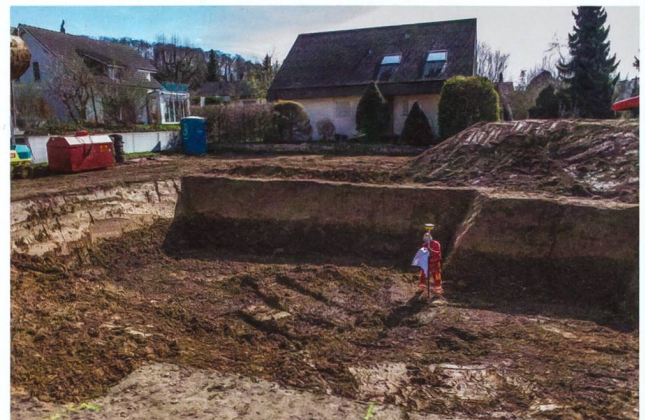
Abb. 34: Hausen-Birkenstrasse 2016–2017 (Hus.016.2). Blick von Nordwesten auf die fertig ausgehobene Baugrube während der Einmessung mit dem Trimble. Die Baugrubenwände zeigen die natürliche Schichtabfolge mit einer mächtigen Schwemmlehm-Auflage am Fusse des Lindhofhügels.
