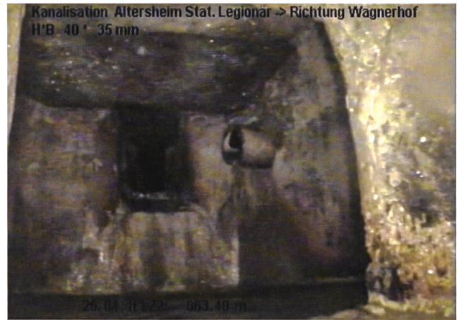
Abb. 27: Windisch-Lindhofstrasse 2013–2016 (V.013.3). Kanalfernsehaufnahme mit Blick von Süden auf die gemauerte «Wasserkammer» auf der Anhöhe des «Wagnerhofs». Das Wasser der römisch/mittelalterlichen Wasserleitung tritt von Süden her in die Kammer, von wo aus weitere Ableitungen nach Windisch bzw. Königsfelden abgehen.
