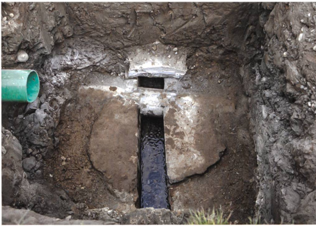
Abb. 28: Hausen-Sportplatz 2016 (Hus.016.1). Blick von Süden in die geöffnete Baugrube mit der laufenden römisch/mittelalterlichen Wasserleitung. Eine Kanalisationsröhre von 1968 quert bzw. stört das alte Bauwerk, dessen intakte Deckplatten in der gegenüberliegenden Baugrubenwand erkennbar sind.
