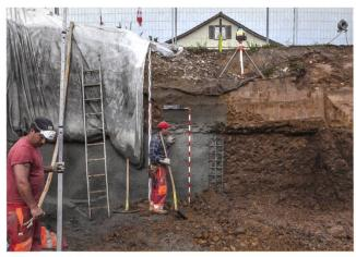
Abb. 29: Hausen-Stückstrasse 2015–2016 (Hus.015.2). Blick von Osten auf die laufenden Bauarbeiten mit dem freigelegten Abschnitt der «toten» römischen Wasserleitung nach Vindonissa. In der Baugrubenwand wird der gemauerte antike Kanal entlang seiner östlichen Wange grob freigelegt, leicht untergraben und anschliessend mit armiertem Spritzbeton gesichert.
