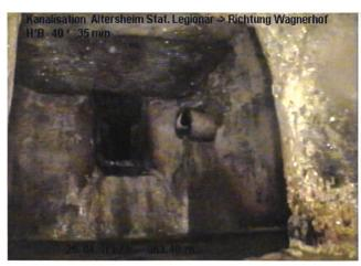
Abb. 27: Windisch-Lindhofstrasse 2013–2016 (V.013.3). Kanalfernsehaufnahme mit Blick von Süden auf die gemauerte «Wasserkammer» auf der Anhöhe des «Wagnerhofs». Das Wasser der römisch/mittelalterlichen Wasserleitung tritt von Süden her in die Kammer, von wo aus weitere Ableitungen nach Windisch bzw. Königsfelden abgehen.
