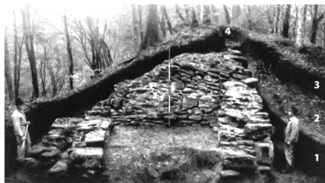
Abb. 16: Möhlin-Riburg/Bürkli (Grabung 1941). Der Westturm der Toranlage nach Abschluss der Freilegungsarbeiten (zur Lage vgl. Abb. 21). Die Aufnahme zeigt, dass die Baugrube für den Westturm sehr wahrscheinlich in den älteren, mutmasslich prähistorischen «Proto-Wall» (1) abgetieft wurde. Dieser wird seinerseits von einer jüngeren, aus Kies und Lösslehm bestehenden Walle (2) überlagert, die offensichtlich erst nach dem Bau der Nordmauer (M7) angeschüttet wurde. Die dunkle Verfärbung des obersten Teils der Walle (3) geht auf Verwitterungs- und Bodenbildungsprozesse zurück. Im Hintergrund (4) zeichnet sich möglicherweise die «Flügelmauer» bzw. deren Raubgrube ab.
