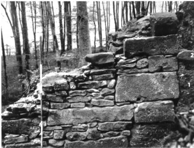
Abb. 14: Möhlin-Riburg/Bürkli (Grabung 1941). Blick an die mehrheitlich aus Spolien bestehende äussere Mauerschale der Nordmauer (M7) des Westturms (zur Lage vgl. Abb. 21). Die unterste Steinlage der andeutungsweise erkennbaren und nach dem Bau des Westturms errichteten «Flügelmauer» (2) liegt auf dem älteren, mutmasslich prähistorischen «Proto-Wall» (1). Vgl. dazu auch Abb. 15 und Abb. 16 sowie die Ausführungen im Text.
