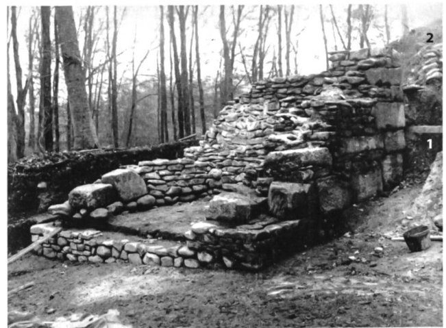
Abb. 15: Möhlin-Riburg/Bürkli (Grabung 1941). Der Westturm der Toranlage nach Abschluss der Freilegungsarbeiten (zur Lage vgl. Abb. 21). Im Hintergrund ist die nach dem Bau des Westturms errichtete, auf dem älteren, mutmasslich prähistorischen «Proto-Wall» (1) stehende «Flügelmauer» (2) zu erkennen. Die Aufnahme illustriert zudem auch den von Laur-Belart (1941, 62) beschriebenen Zustand des Westturms sehr treffend: «Das Mauerwerk ist sehr hart, aber von beispielloser Unförmigkeit. Kreuz und quer sind die Steine gelegt, die Fundamente laufen schief, wo Verband sein sollte, sieht man Fugen usw.»
