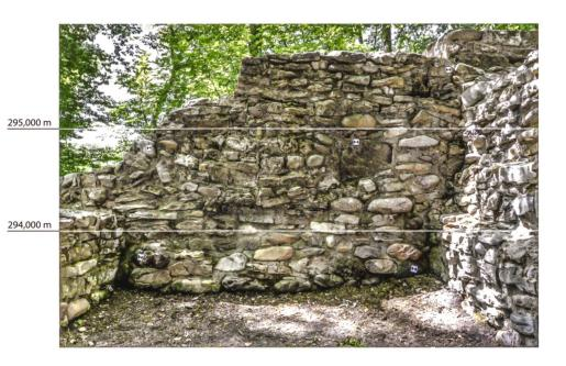
Abb. 25: Möhlin-Riburg/Bürkli (Mol. 014.5). Blick an die innere Schale, der z.T. mithilfe von Spolien errichteten Nordmauer (M7) des Westturms (zur Lage vgl. Abb. 21). Die beiden markanten Rücksprünge deuten darauf hin, dass M7 etappenweise aufgemauert und nach oben hin verjüngt wurde, um Baumaterial zu sparen. Blick nach Norden.
