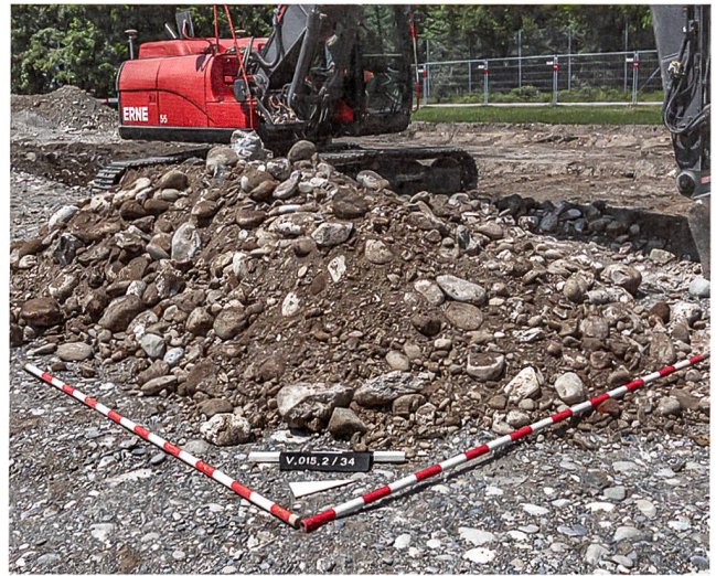
Abb. 12: Windisch-Königsfelden (KJPZ) 2015 (V.015.2). Was vom Grossbau («Arsenal») übrig blieb: Endgültiger Abbruch der 1938 und 2015 dokumentierten Fundamente des römischen Grossbaus.
