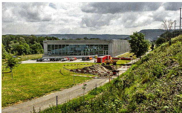
Abb. 23: Windisch-Mülimatt 2015 (V.015.4). Blick von Südwesten auf die Aareniederung der «Mülimatt» mit der 2008 gebauten Sporthalle, davor die Baugrube der Startgrube. Rechts der aufgeschüttete Bahndamm der SBB, der weiter östlich den «Schutthügel» des Legionslagers überdeckt.
