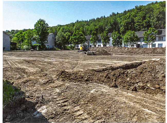
Abb. 15: Windisch-Dägerli (Sternmatte) 2015 (V.015.3). Blick von Nordosten auf die vorgezogenen und archäologisch begleiteten Baggerarbeiten. Die Neubausiedlung im Hintergrund steht auf einem 1993/94 ausgegrabenen römischen Brandgräberfeld, dem «Südfriedhof» von Vindonissa.
