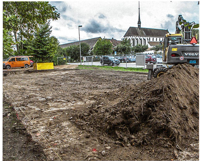
Abb. 13: Windisch-Königsfelden (Wohnprovisorium) 2015 (V.015.6). Blick von Nordosten auf die abhumusierte Stellfläche für einen weiteren provisorischen Containerbau der PDAG. Inmitten des Legionslagers Vindonissa konnte dieser erneut als archäologieverträglicher «Bau über den Ruinen» erstellt werden.
