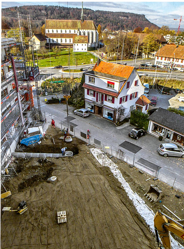
Abb. 26: Windisch-Lindhofstrasse (Altersheim) 2013–2015 (V.013.3). Blick von Süden auf die laufende Baustelle mit der Klosterkirche Königsfelden im Hintergrund; die gemauerte Wasserleitung ist nach der Dokumentation wieder mit Geovlies zugedeckt.
