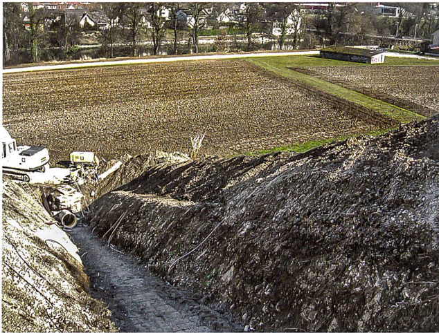
Abb. 14: Windisch-Reussprallhang 2013–2015 (V.013.8). Blick von Westen auf die Werkleitungsarbeiten am Steilhang zur Reuss. Hinten rechts die heutige Strassenbrücke am «Fahrrein», wo im Mittelalter und wohl auch in römischer Zeit eine Fähre über den Fluss ging.
