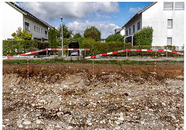
Abb. 16: Windisch-Dägerli (Sternmatte) 2015 (V.015.3). Blick von Süden auf das Profil am nördlichen Baugrubenanrand. Unter der hier nur dünnen Humusdecke liegt eine Abfolge von kiesigem Lehm zu unverwittertem Kies mit unruhig verlaufender Schichtengrenze. Hierbei handelt es sich nicht um anthropogene Befunde (Gruben o.ä.), sondern um geologische Phänomene (Kryoturba­tion).
