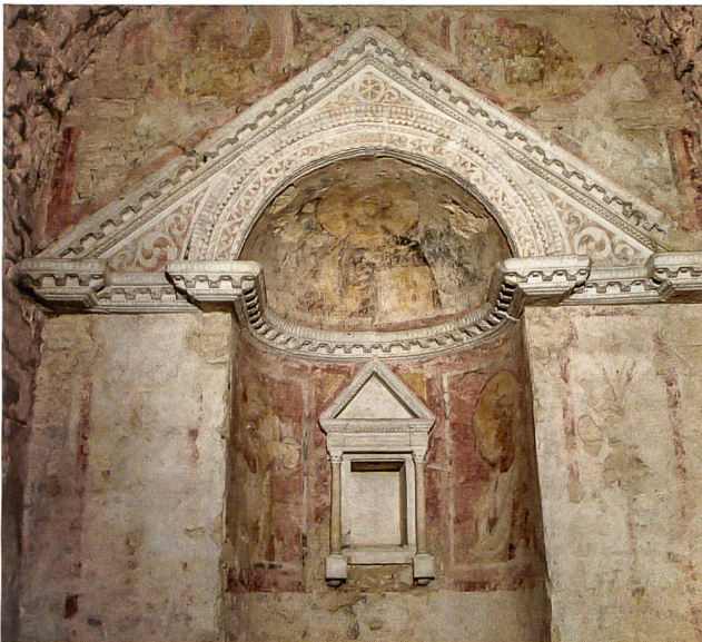
Abb. 7: Tempio del Clitunno bei Spoleto (I). Blick ins Innere mit Konsolen entlang dem Gebälk und blockförmigen Konsolen als Stützen der Schrein-Säulchen (a). Rom (I), Casa dei Cavalieri di Rodi. Wand mit einer Serie von kleinen Konsolen, aus den Grabungen in der Kirche des Hl. Basilianus im Forum Romanum (b).
