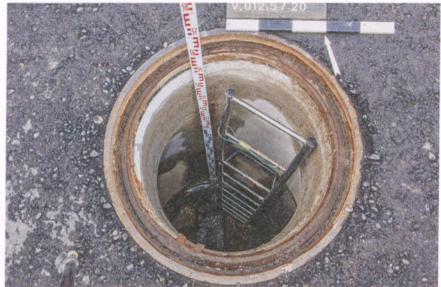
Abb. 17: Windisch-Reisezentrum Knecht 2012–2014 (V.012.5). Blick in den modernen, auf die alte Wasserleitung aufgesetzten Betonschacht. 3,70 m unter dem neu erstellten Parkplatzbelag fliesst weiterhin «römisches» Wasser.
