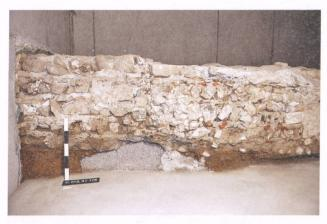
Abb. 18: Windisch-Lindhofstrasse (Altersheim) 2013–2014 (V.013.3). Der erweiterte Keller des Altersheims im Rohbauzustand. Blick von Osten auf den neu freigelegten Fundamentabschnitt der alten Wasserleitung beim «Durchbruch» durch die neue Gebäudeaussenmauer (ganz links). Rechts vom Massstab, unter der Wasserleitung, das Negativ einer neuzeitlichen, nun ausser Betrieb gesetzten und mit Magerbeton verfüllten Sickerleitung.
