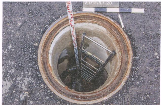
Abb. 17: Windisch-Reisezentrum Knecht 2012–2014 (V.012.5). Blick in den modernen, auf die alte Wasserleitung aufgesetzten Betonschacht. 3,70 m unter dem neu erstellten Parkplatzbelag fliesst weiterhin «römisches» Wasser.
