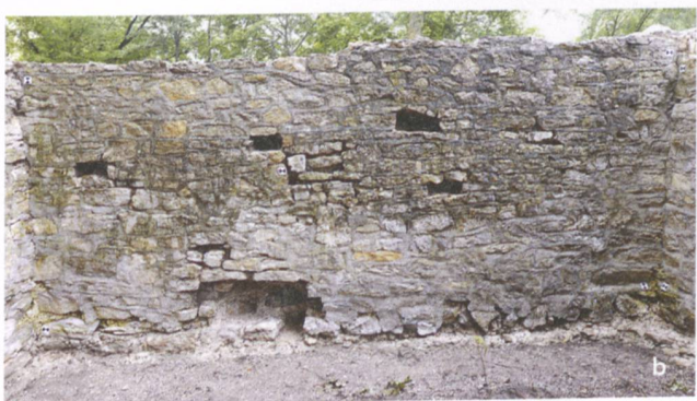
Abb. 9: Koblenz-Kleiner Lauf (Kob.014.1). Zustand der Mauern nach der Reinigung des Mauerwerks und Entfernung der Schadstellen an der Südostecke (a), an der inneren Mauerschale der Ostmauer (b) und an der äusseren Mauerschale der Ostmauer (c).
