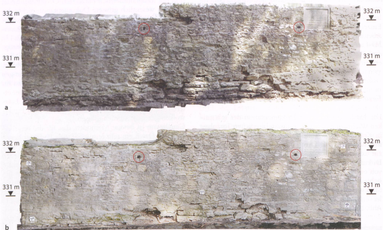
Abb. 5: Koblenz-Kleiner Lauf (Kob.014.1). Ansichten der äusseren Schale der Westmauer des Wachtturms. a) Aufnahme mit einem 3D-Laserscanner, b) aus einem 3D-Modell generierte 3D-Ansicht. Zustand nach Reinigung.
