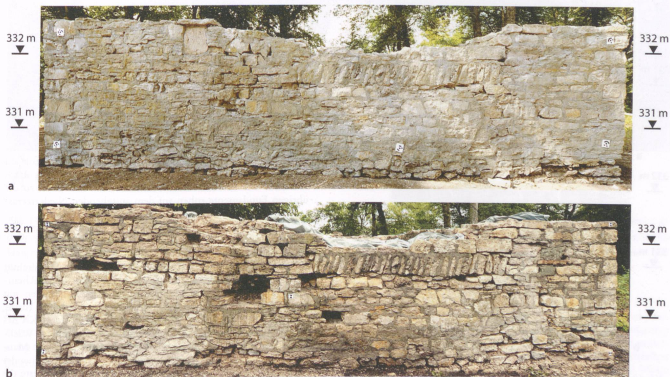
Abb. 12: Koblenz-Kleiner Lauf (Kob.014.1). Fotogrammetrisch entzernte Ansichten der äusseren Schale der Südmauer. Zustand nach Entfernen der Betonabdeckung und Reinigung (a) bzw. nach Entfernen der Schadstellen (b).
