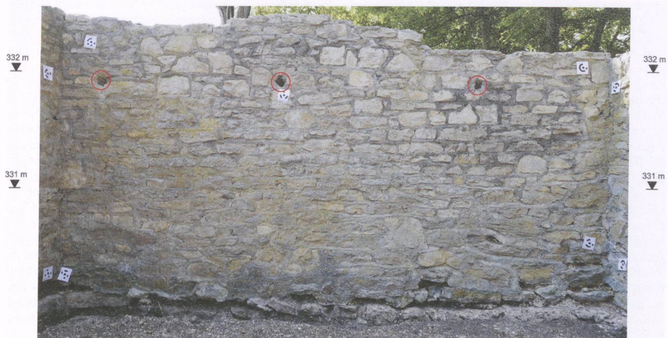
Abb. 11: Koblenz-Kleiner Lauf (Kob.014.1). Fotogrammetrisch entzernte Ansicht der inneren Schale der Westmauer mit den (nach der Sanierung nicht mehr sichtbaren) Gerüstebellöchern. Zustand nach Reinigung.
