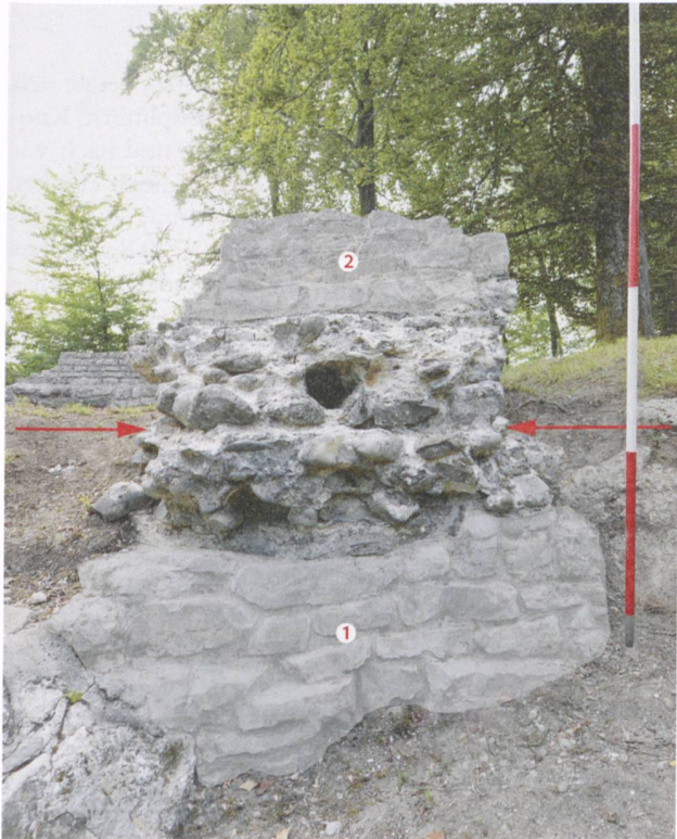
Abb. 22: Möhlin-Fahrgraben (Mol.014.3). Die Abbruchkante der Südmauer (Blick nach Osten). Im antiken opus caementitium sind die Negative der mittleren und obersten Lage der Holzarmierung zu erkennen. Die mit Pfeilen gekennzeichnete Fuge im antiken Gussmauerwerk deutet darauf hin, dass zwischen dem Einbringen des unteren und oberen Teils des Fundaments einige Zeit verstrichen ist. Die grau eingefärbten Mauerpartien kennzeichnen die moderne Unterfangungsmauer (1) bzw. moderne Ergänzungen (2).
