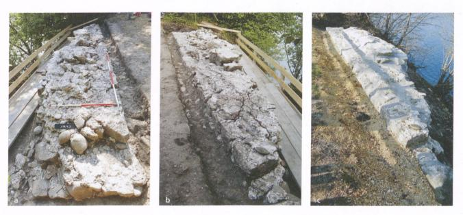
Abb. 25: Möhlin-Untere Wehren (Mol.014.4). Blick nach Osten (a) bzw. Westen (b) auf die Abbruchkrone der Südmauer des Wachturms sowie Zustand nach Abschluss der Konservierung im Jahr 2014 (c).
