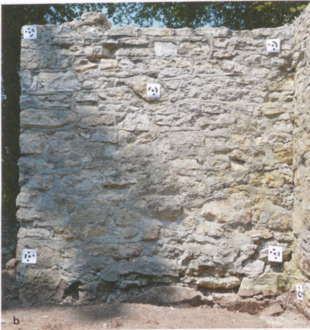
Abb. 3: Koblenz-Kleiner Laufen (Kob.014.1). Nicht entzerrte (a) und fotogrammetrisch entzerrte (b) Aufnahme der inneren Mauerschale des Ostabschnitts der Nordmauer. Zustand nach Reinigung.
