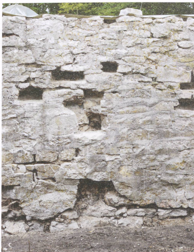
Abb. 9: Koblenz-Kleiner Lauf (Kob.014.1). Zustand der Mauern nach der Reinigung des Mauerwerks und Entfernung der Schadstellen an der Südostecke (a), an der inneren Mauerschale der Ostmauer (b) und an der äusseren Mauerschale der Ostmauer (c).
