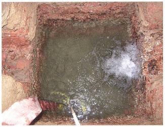
Abb. 12: Windisch-Dohlenzelgstrasse/Jurastrasse 2012 (V.012.3). Blick von oben auf das Absetzbecken von «Schacht B» der römischen Wasserleitung. Schlamm und Sinter sind beseitigt, sodass von Südwesten her (rechts) wieder ungehindert Wasser einfliessen und nach Norden (links) abfliessen kann.
