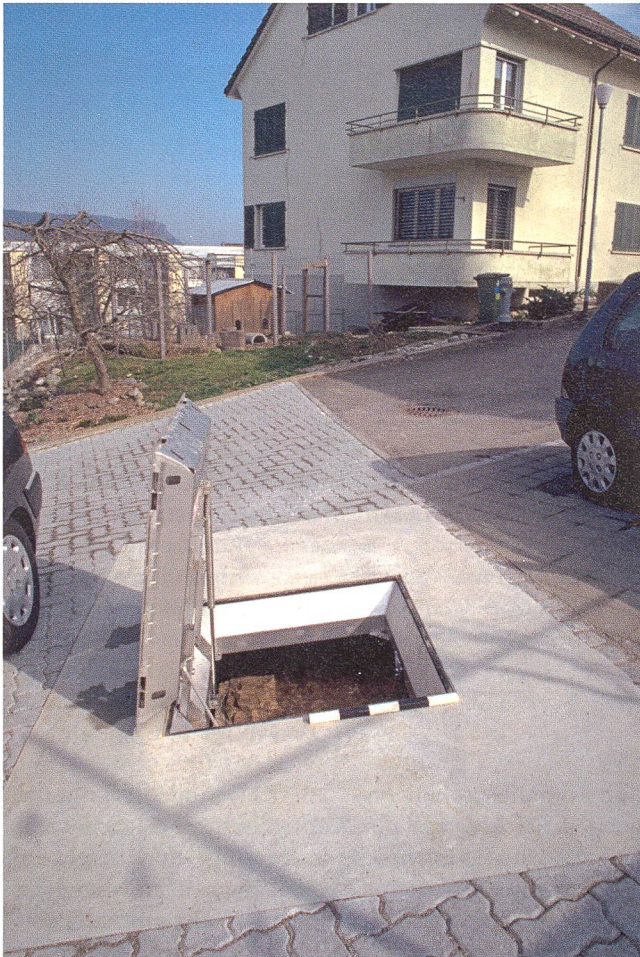
Abb. 10: Windisch-Wagnerhof 2011/12 (V.011.12). Blick von Südwesten auf die sanierte und dank eines Schachtdeckels zugänglich gemachte Situation mit alter und neuer Wasserleitung.
