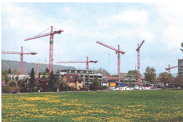
Abb. 4: Baukräne beherrschen seit Jahren das Ortsbild von Windisch. Blick vom Amphitheater im Frühjahr 2013 nach Nordosten.
