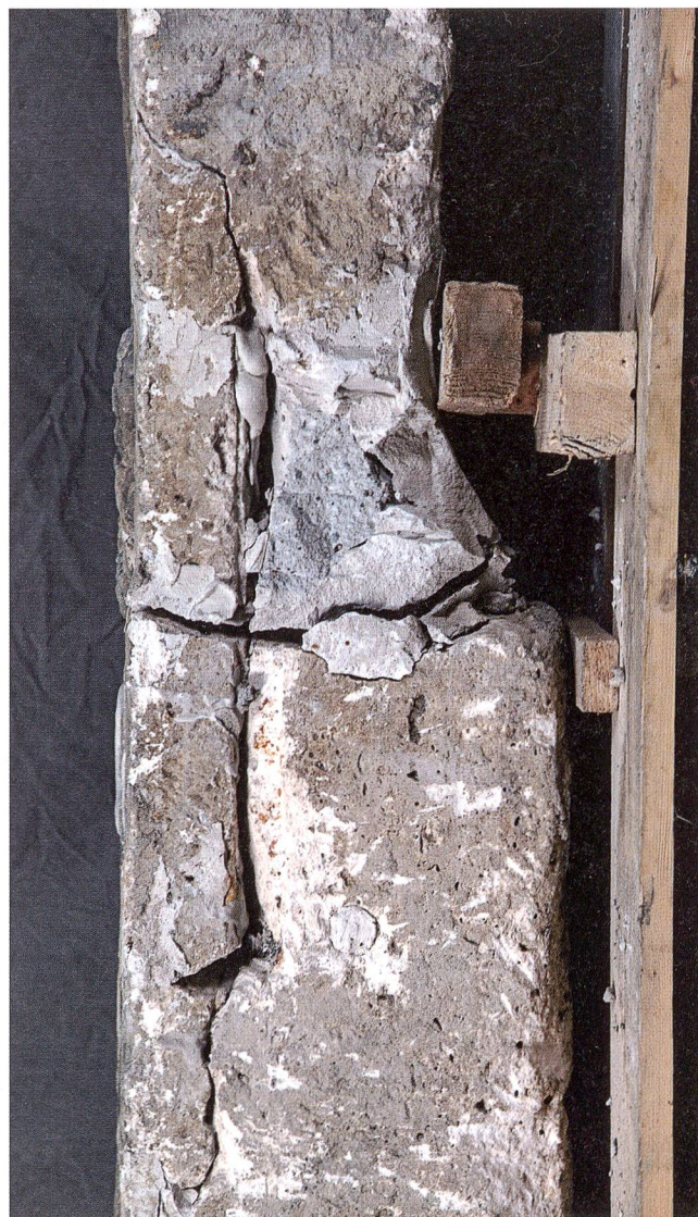
Abb. 14: Seitlich eingearbeitete Nut aus der Fundzeit für die Zusammensetzung der beiden Steinfragmente mittels Eisenklammer.
