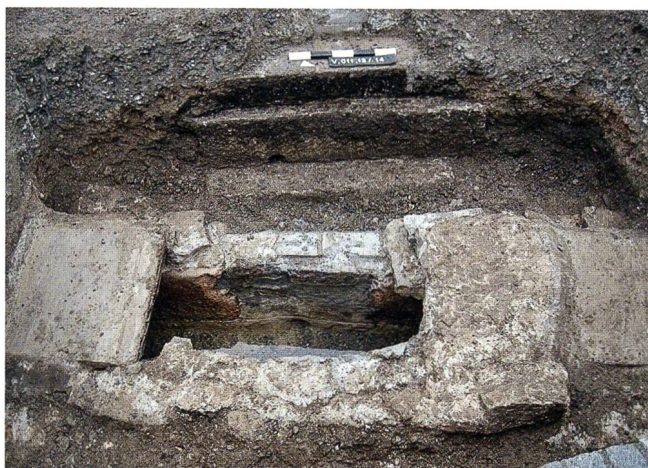
Abb. 19: Windisch-Wagnerhof 2011 (V.011.12). Die stark gestörte römische Wasserleitung mit Resten der antiken Bausubstanz (im Vordergrund) weist eine runde Abflussöffnung auf, durch welche Wasser in eine neuzeitliche Wasserkammer (im Hintergrund) tritt. Von dort fliesst das Wasser in einer modernen Druckleitung zum Springbrunnen der Klinik Königsfelden. Ansicht aus Osten.
