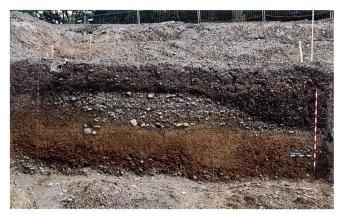
Abb. 16: Windisch-Alte Zürcherstrasse 2011 (V.011.3). Strassenkörper der römischen Strasse von Vindonissa nach Aventicum. Die massive Störung des Trassees ist deutlich zu sehen. Ansicht aus Westen.
