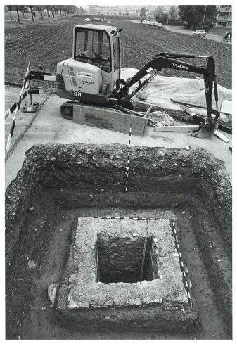
Abb. 20: Windisch-Chapfstrasse/Im Winkel 2011 (V.011.11). Blick auf den freigelegten, über 3 m tiefen Kontrollschacht Nr. 2 der römischen Wasserleitung. Im Hintergrund, auf freiem Feld, der gleichfalls freigelegte Schacht Nr. 4. Ansicht aus Nordosten.
