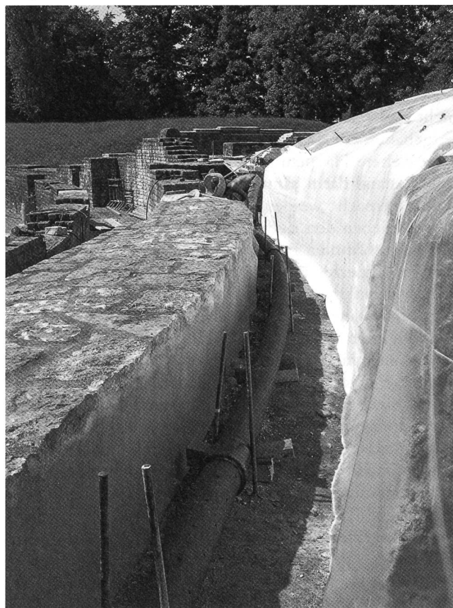
Abb. 6: Amphitheater. Einbau Sickerleitung an der Aussenseite der Couloirmauer, am Fuss der Erdböschungen der Cavea (im Bild Mauer 33 in S.2008.14). Die Sickerleitung besteht aus einem perforierten PVC-Rohr. Die Mauerschale der Couloirmauer wurde mit einem wasserundurchlässigen Mörtel abgedichtet.
