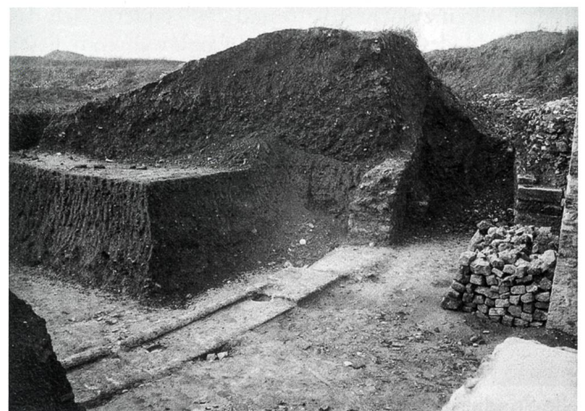
Abb. 3: Amphitheater. Östliche Arenaschwelle (Pos. 617) bei der Freilegung im Jahr 1900. Auf der rechten Seite die teilweise freigelegte Podiumsmauer/ Arena-Umfassung und die Couloirmauer. Ansicht aus Osten.
