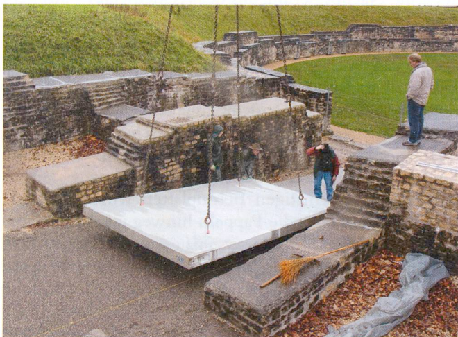
Abb. 1: Einbau der Betonrampe beim Eingang Ost (Foto T+U AG).
