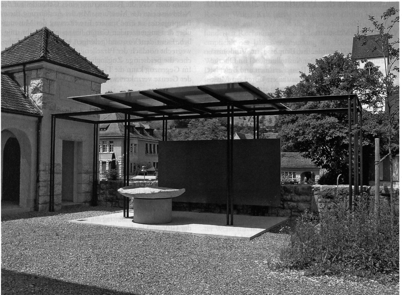
Abb. 1: Neuer Schutzbau im Garten des Vindonissa-Museums (Foto T+U AG).
