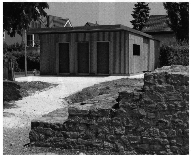
Abb. 1: Nebengebäude mit Geräteraum, Werkstatt und WC-Anlagen (Foto T+U AG).
