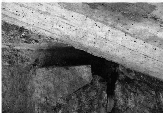
Abb. 7: Windisch-Friedhof-Bad. a) Nachträglich eingesetzte Türschwelle in M7 (Pos. 134; BP 2). Blick nach Westen. b) Viertelrundstab (Pos. 121; BP 2) an M5 (links, unter der Betonwand des Schutzbaus) und M24 (Pos. 139; BP 2) (rechts). In der Bildmitte M2 (BP 4).
