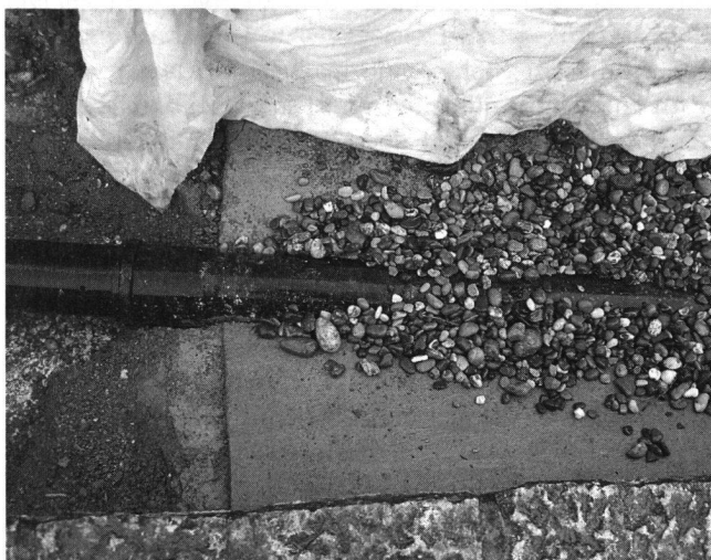
Abb. 1: Sickerleitung mit Einlauf fläche hinter der mittleren Ringmauer (Foto T+U AG).
