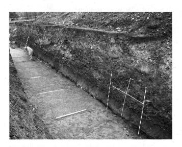
Abb. 12: Windisch-Mülimatt. Leitungsgraben für den neuen Hauptsammelkanal. Vorbereiten des Grabenbettes für das Kanalrohr. Im Südprofil ist über dem anstehenden, gewachsenen Silt eine ca. 0,2 m starke Kiesschicht (römischer Weg oder Strasse?) erkennbar. Darüber liegen moderne Verfüllschichten, die mit dem Bau des Bahndammes (1855/1862) in Zusammenhang stehen dürften.
