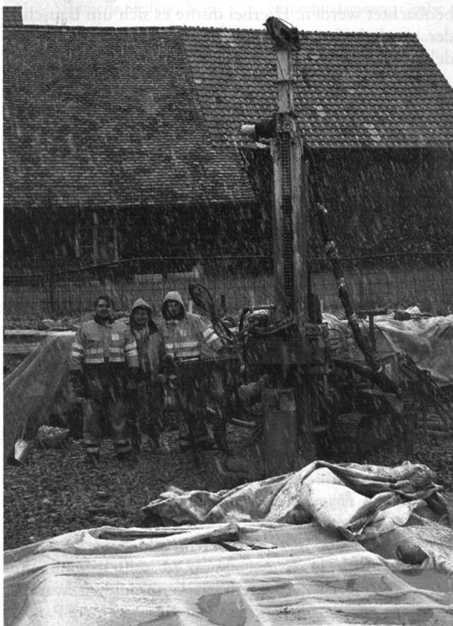
Abb. 7: Windisch, «Archäologiestätte via et porta praetoria ». Bohrung für die Fundation eines Stützpfeilers im Bereich der via praetoria .
