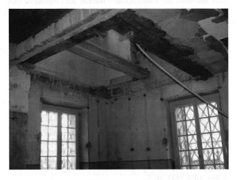
Abb. 8: Ansicht des ehemaligen Büros von Konservator Eckinger nach Entfernung der Verkleidung. In der Decke der Durchbruch für das neue Treppenhaus (Foto Architekturbüro Tschudin+Urech, Hausen).
