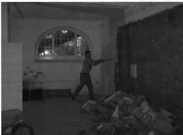
Abb. 1: Ausbruch einer nachträglich erstellten Zwischenwand im Untergeschoss zur Vergrösserung des Wechselausstellungsraumes (Foto T+U AG).
