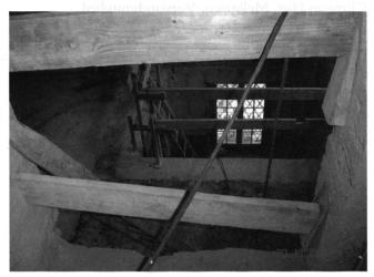
Abb. 2: Deckendurchbruch über drei Geschosse zum Einbau einer neuen Treppe vom Untergeschoss ins 1. Obergeschoss (Foto T+UAG).
