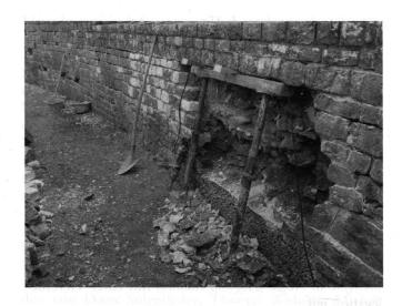
Abb. 2: Grossflächige Ablösungen der Mauerschale an der mittleren Ringmauer bedingen eine neue, zusätzliche Verankerung (Foto T+UAG).
