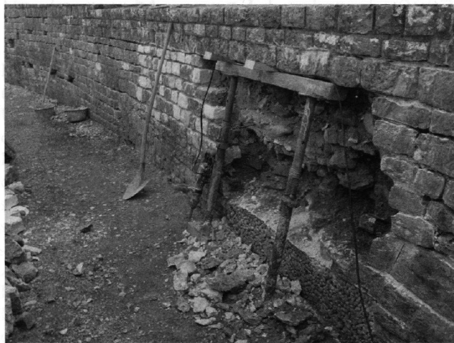
Abb. 2: Grossflächige Ablösungen der Mauerschale an der mittleren Ringmauer bedingen eine neue, zusätzliche Verankerung (Foto T+U AG).
