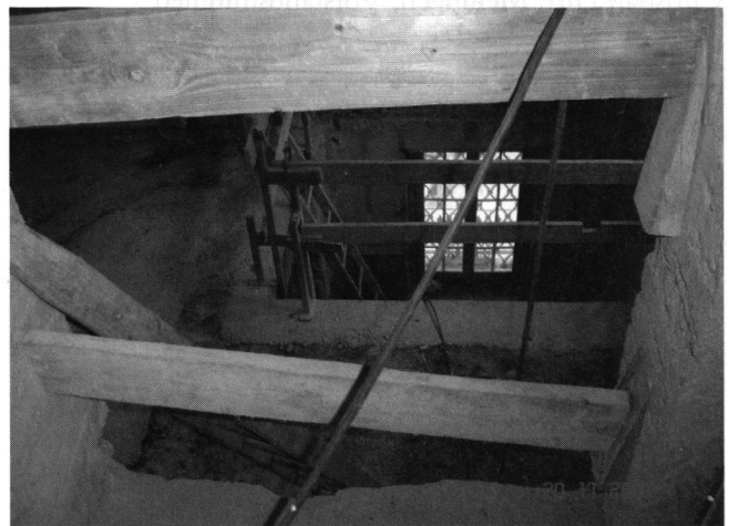
Abb. 2: Deckendurchbruch über drei Geschosse zum Einbau einer neuen Treppe vom Untergeschoss ins 1. Obergeschoss (Foto T+U AG).
