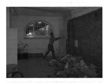
Abb. 1: Ausbruch einer nachträglich erstellten Zwischenwand im Untergeschoss zur Vergrösserung des Wechselausstellungsraumes (Foto T+U AG).
