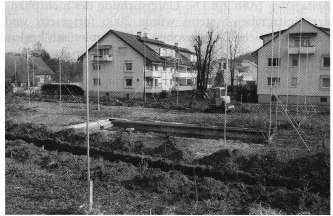
Abb. 8: Windisch-Mülligerstrasse. Sondierung mit Baggerschnitten. Ansicht von Norden.
