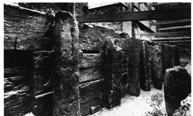
Abb. 11: Uferbefestigung am Rhein mit Eichenpfosten und -bohlen in der römischen Stadt Colonia Ulpia Traiana-Xanten/D (v. Petrikovits 1952, Taf. 21, Abb. 1).
