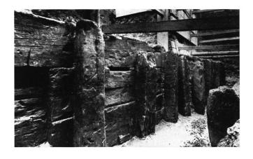
ben<sup>16</sup>. Der von Holzwand und Bretterboden eingefasste Hohlraum war mit Geröll und sandigem Material aufgefüllt, womit dem ganzen Bau die nötige Stabilität verliehen wurde (Abb. 12). Vom Niveau des ufernahen Flussbetts aus gemessen, erreichte die hölzerne Quaiwand nach Ausweis der Mächtigkeit des Steinpakets eine Höhe von mindestens 1,6 m (Ländestrasse).
