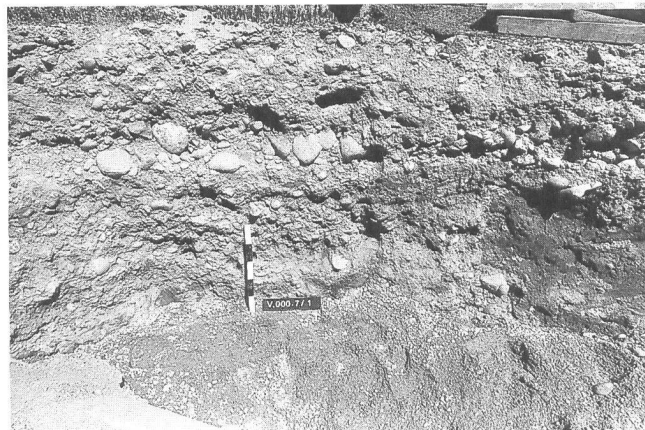
Abb. 7: Windisch-Zürcherstrasse 2000 (V.000.7): Blick an die nördliche Wand des Leitungsgrabens: Am oberen Bildrand der geschnittene Teerbelag, darunter der grobkiesige Strassenkoffer der Zürcherstrasse; in der linken Bildhälfte im Bereich des Massstabes der feinerkiesige römische (?) Strassenkörper, der rechts von der Bildmitte durch einen Graben begrenzt wird, der mit dunkelgrauem Material verfüllt ist (Die modernen Leitungen sind bereits verlegt und mit Kies oder Magerbeton bedeckt). Profilansicht aus Süden.
