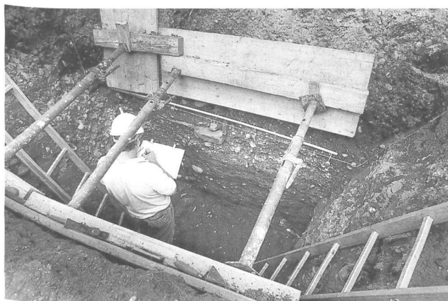
Abb. 10: Windisch-Dorfstrasse (47) 2000 (V.000.9): Mit der zweiten Sondierung wurde nahe der heutigen Dorfstrasse eine kleine Konstruktion aus einer Tonplatte, einem Leistenziegelfragment und aus einer Reihe Holzziegel erfasst. Schrägeblick aus Osten.
