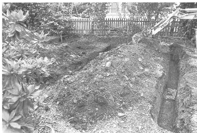
Abb. 12: Windisch-Dorfstrasse (60) 2000 (V.000.10): Überblick über die drei Gräbchen für die Fundamentriegel der Garage. Im nördlichen Gräbchen (rechts im Bild) kann die Oberfläche der quer verlaufenden römischen Mauer erkannt werden.
