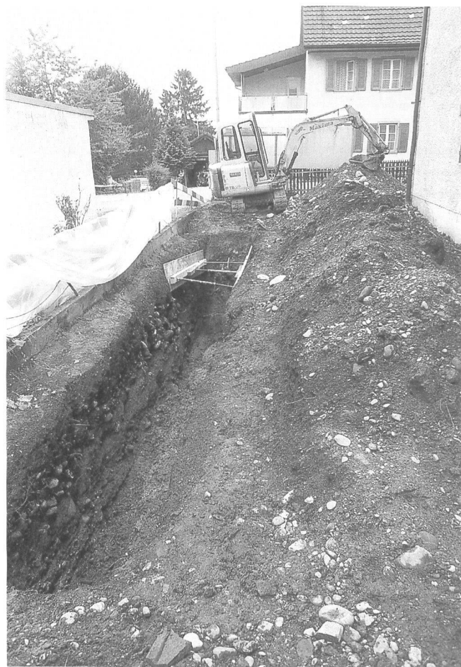
Abb. 9: Windisch-Dorfstrasse (47) 2000 (V.000.9): Die Situation des Baggersondierschnittes zwischen der Liegenschaft Dorfstrasse 47 und dem Restaurant Löwen.
