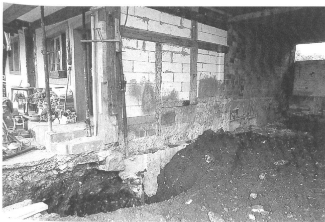
Abb. 3: Windisch-Dorfstrasse (30) 2000 (V.000.6): Ansicht der Mauerunterfangung, aus Südosten.
