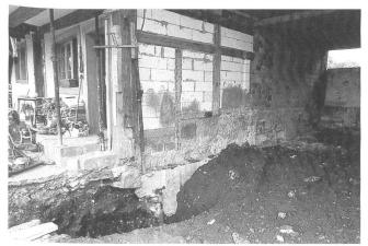
Abb. 3: Windisch-Dorfstrasse (30) 2000 (V.000.6): Ansicht der Mauerunterfangung, aus Südosten.
