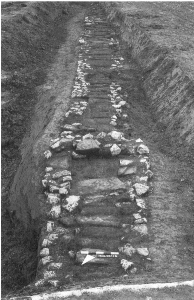
Abb. 18: Hausen-Römerstrasse 1998 (Hus.98.1): Der aufgedeckte römische Kanal am Rand der Baugrube; Im vorderen Drittel die leichte Verbreiterung des Kontroll- und Putzschachtes. Schrägaufsicht aus Norden.
