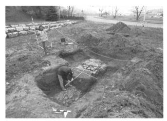
Abb. 17: Windisch-Jurastrasse 1998 (V.98.2): Die aufgedeckte römische Wasserleitung: Im Bildzentrum die Abdeckplatten des neu lokalisierten Kontrollschachtes; vorne links steht H. Huber auf der Abdeckung des Kanals gegen Vindonissa. Schrägaufsicht aus Norden.
