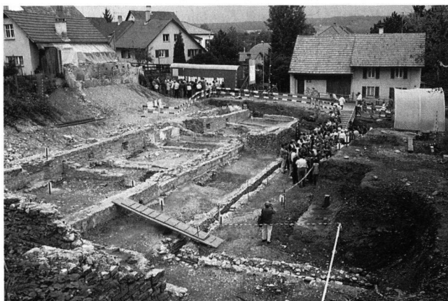
Abb. 3 Windisch-Ländestrasse/Grundstück Tschanz (V. 92.3 + V. 93.1): Übersichtsaufnahme aus SW. Im Vordergrund eine hohe Hangstützmauer, links die Raumflucht des eigentlichen Gebäudes, rechts der offene Innenhof mit dem Regenwasserkanal.
