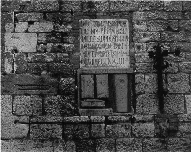
Abb. 13: Assisi (Italien). Mittelalterliche Masse am Turm des Palazzo del Popolo. Das metallene Mass links oben ist die grosse Elle zum Vindonissa-Fuss.
