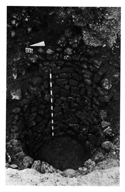
Abb. 28 Beispiel einer Schachtwandung in Trockenmauertechnik.
