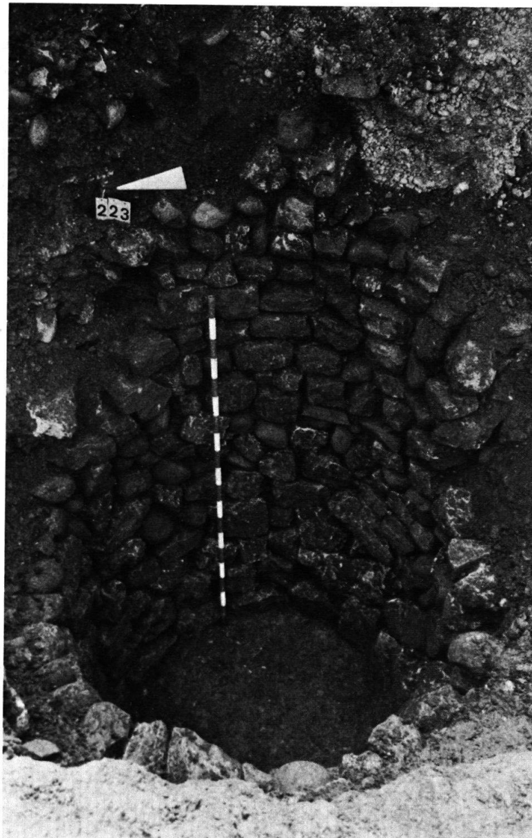
Abb. 28 Beispiel einer Schachtwandung in Trockenmauertechnik.
